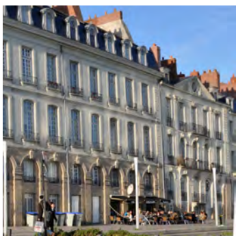
Façade des hôtels particuliers de la Petite Hollande
