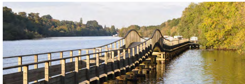
Passerelle piétonne sur l'Erdre
