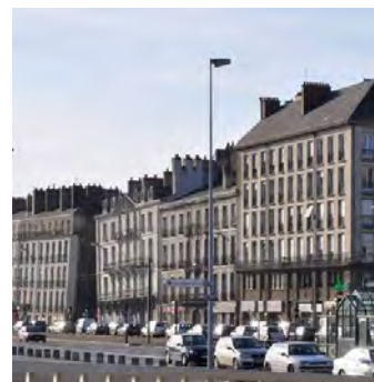
Affaissement des façades sur les quais de la Fosse
