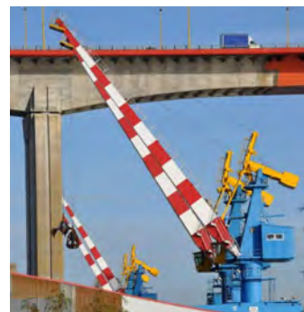
Paysage aérien des grues et du pont de Cheviré
