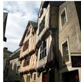
Maison à pans de bois : exemple rue Bossuet (photo)
