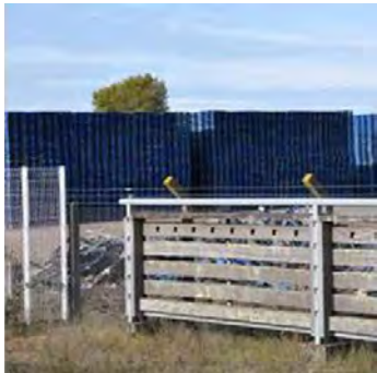
Barrière dans une zone portuaire
