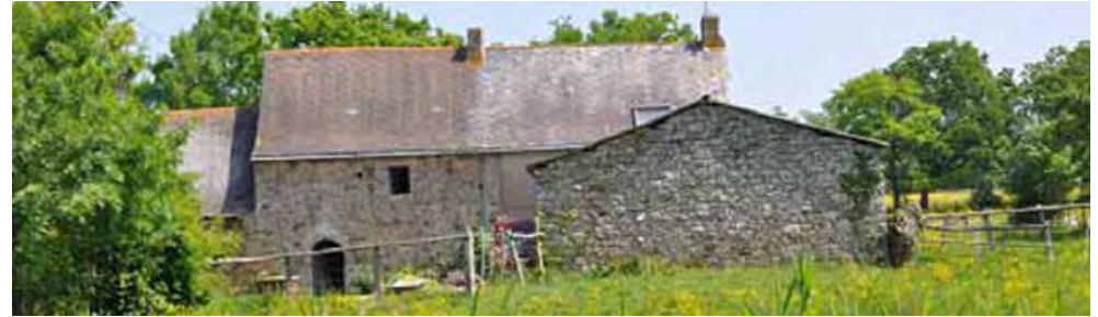
Habitat rural en charnière entre terres hautes et terres basses
