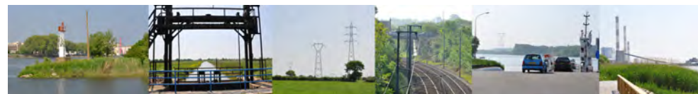
Infrastructures et économie.
