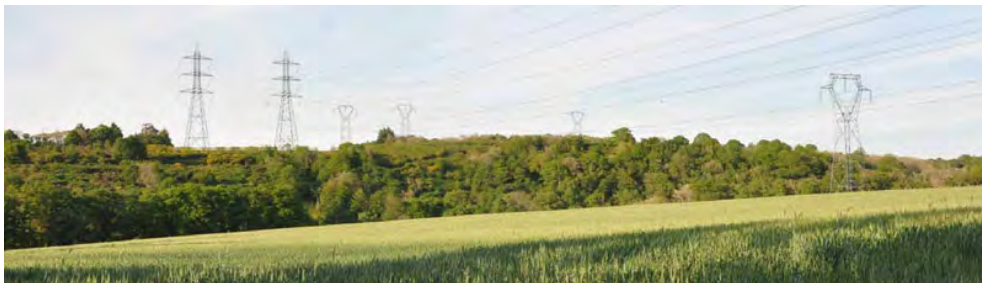
Pylônes électriques sur le Sillon de Bretagne
