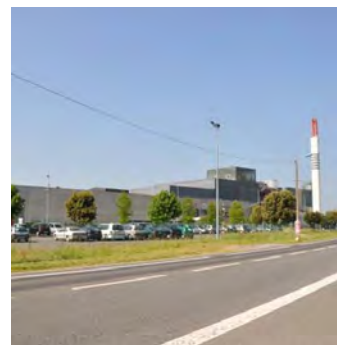
Un bâti industriel monumental qui marque le paysage
