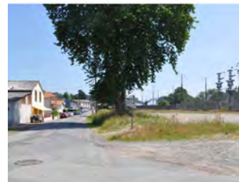
Effet de rupture des infrastructures
