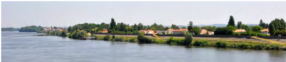
Développement urbain le long de la levée de la Divatte
