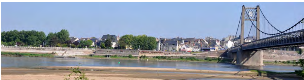
Façade fluviale d'Ancenis
