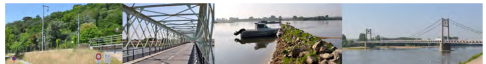
Infrastructures et économie
