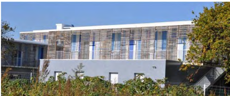
ZAC tertiaire en cours d'aménagement
