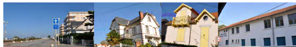
Architecture balnéaire du sud de l'unité
