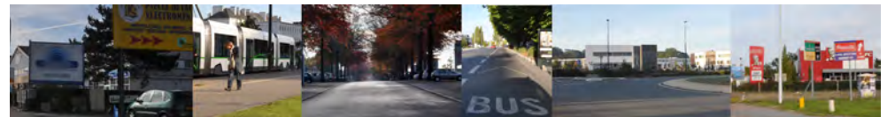
Infrastructures et économie
