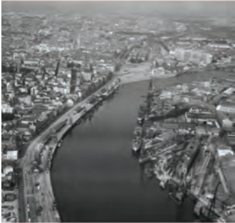
Nantes – chantiers et port (Source : site internet des Archives départementales de Loire Atlantique)
