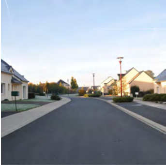
Lotissement à Carquefou
