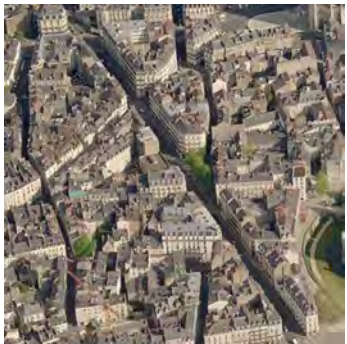
Rue de Strasbourg (Source : BING)
