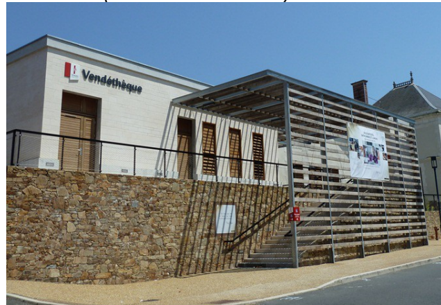
UP45-50-03 Les entreprises de requalification du patrimoine ancien peuvent contribuer à valoriser le paysage urbain : sur l'exemple ci-dessus, l'aménagement d'une médiathèque participe à la réhabilitation d'un immeuble du XIXème siècle. (La Châtaigneraie) (Source : Conseil général de la Vendée)
