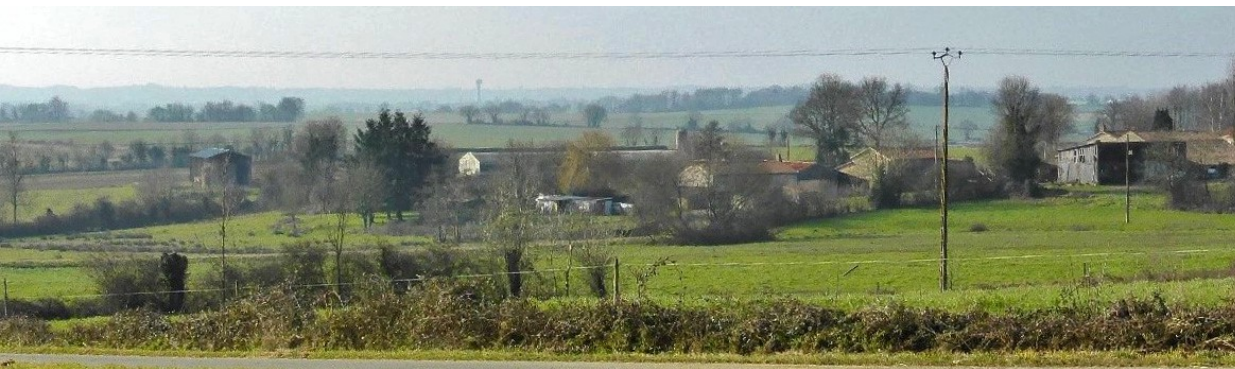
UP45-50-06 Modèle d'intégration de bâtis agricoles : implantation en point bas, architecture peu imposante, continuité avec le bâti existant (Bazoges-en-Pareds)
