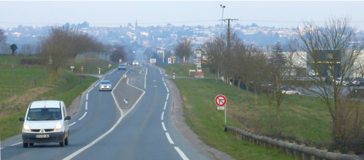
UP45-50-04 L'implantation en retrait des bâtiments d'activités en entrée de ville et l'alignement d'arbres sur la bande enherbée permettent de préserver un paysage plus qualitatif (La Châtaigneraie)
