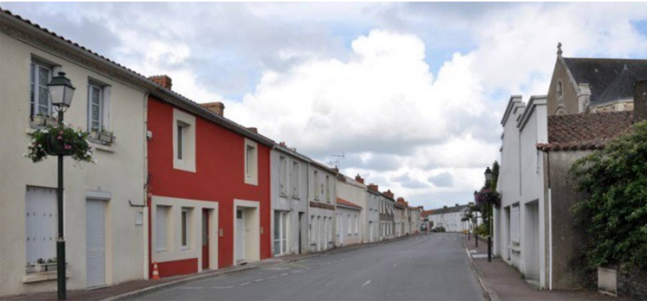
UP40-30-07 Des structures de bourgs ruraux encore compactes (Saint-Etienne-de-Mer-Morte)
