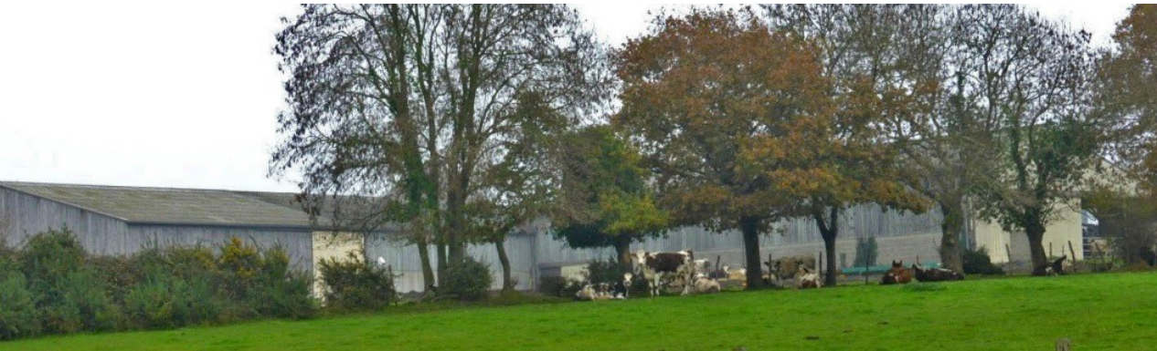
UP40-50-04 Bardage bois et implantation à l'arrière d'un bocage favorisent une bonne intégration paysagère des constructions agricoles (Frossay)
