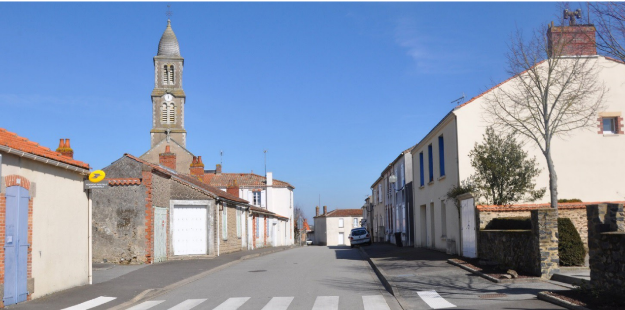
UP40-20-13-Des bourgs qui mêlent les volumes bâtis modestes et blanc du littoral aux maisons en granit ou enduites à étage du bocage (La Boissière-des-Landes)
