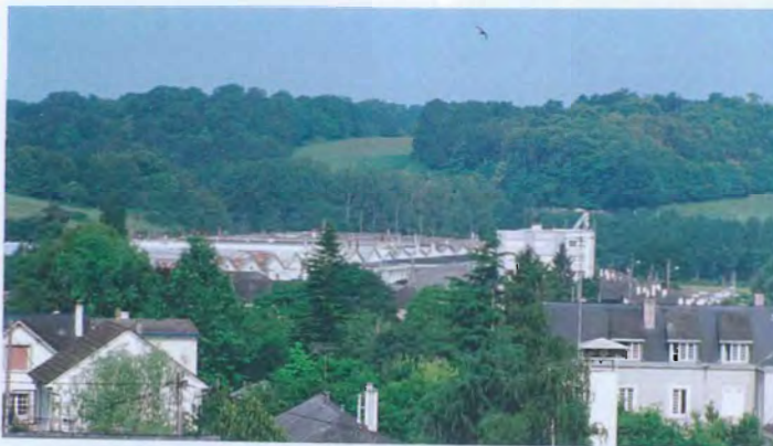
Un site industriel bien cerné par une végétation dense. Un choix d'implantation en fond de vallée qui limite fortement les problèmes d'impact visuel.
