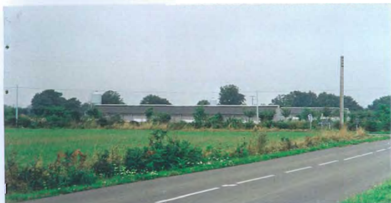
Une volumétrie, un appui et un renforcement par la végétation bien adaptés à l'environnement paysager.
