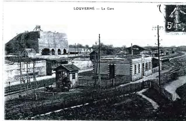
Louverné : Un des fours à chaux de la commune, localisé près de la gare. Le transport ferroviaire a permis l'industrialisation de la production de la chaux.
