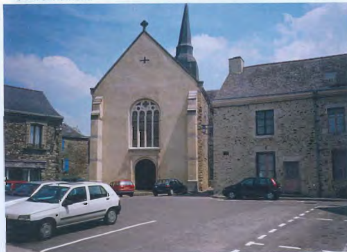
L'enduit à la chaux aérienne : l'enduit traditionnel de la Mayenne. Les maçonneries de moellons, originellement destinées à être enduites, ne le sont plus toujours.
