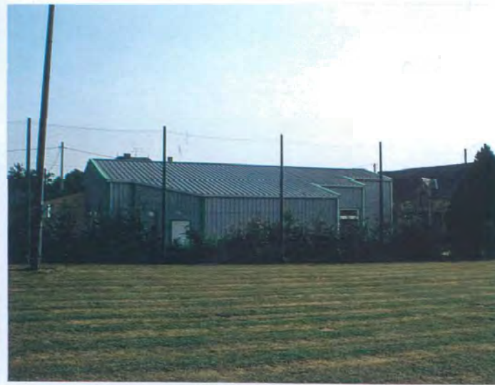
La salle de loisir : salle contemporaine édiflée avec un bardage métallique réfléchissant difficile à intégrer.
