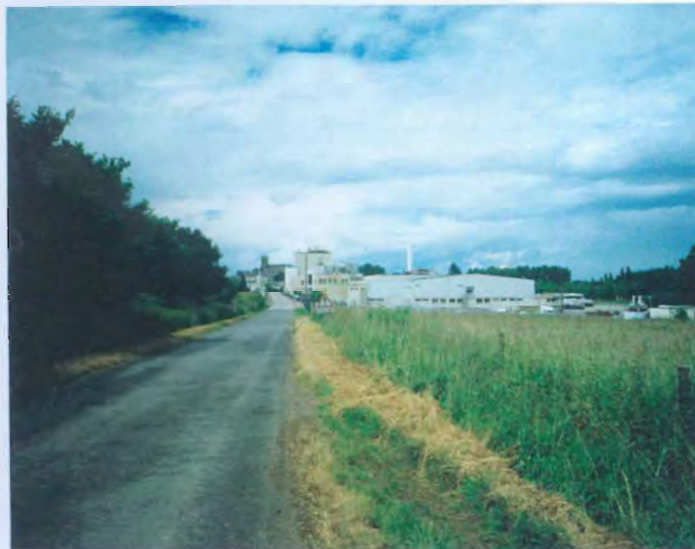
Bâtiment industriel au pied du faubourg S t -Clément : Une couleur moins claire, en rapport avec les tons du bâti voisin et des végétaux pourraient atténuer l'impact visuel.
