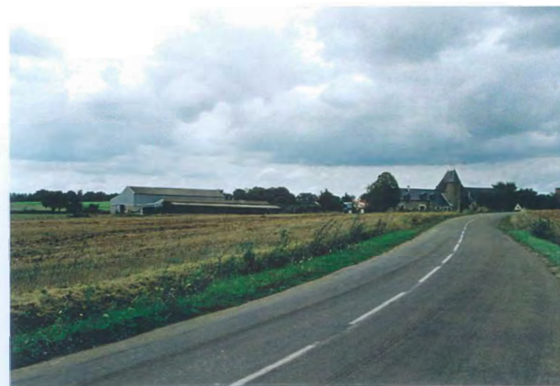
Les extensions de cette ferme sont plus visibles que le patrimoine ancien pourtant d'une grande qualité.
