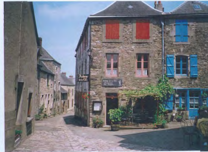
Ensemble de maisons de caractère : rue de la ville close mettant en évidence les matériaux traditionnels et caractéristiques locales : grès, brique, chaux, ardoise, menuiseries de bois peint, un bâti dense, contigu, aux formes variées...
