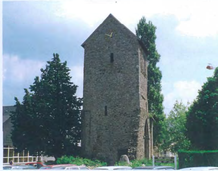
Le clocher du faubourg S t -Georges : noyau initial de l'agglomération à quelques distances de l'ancien château, il domine la place voisine. La mise en valeur de ce genre de patrimoine permet d'affirmer l'identité de l'agglomération.
