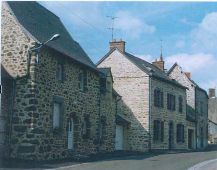
Un bâti ancien de caractère : matériaux traditionnels, rythmes créés par des ruptures d'alignement, formes variées mais courantes en Mayenne (ouvertures, toit), contiguïté de bâti...
