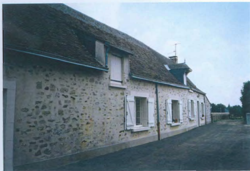
Des matériaux traditionnels encore très présents dans les éléments bâtis.
