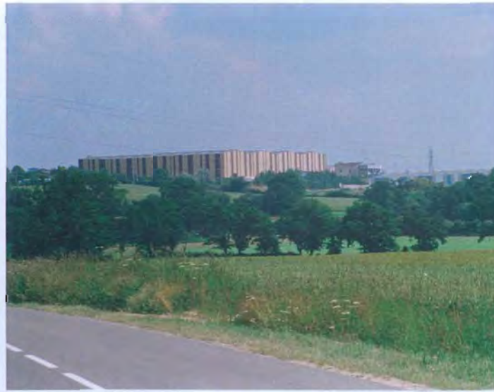
Un bâtiment industriel en site sensible : une position sur crête sensible (haies bocagères peu fournies), des couleurs vives dans un environnement naturel qui ne facilitent pas l'intégration de ces bâtiments d'activité industrielle. Un choix de site moins sensible ainsi que des tons appropriés peuvent atténuer cet impact visuel.
