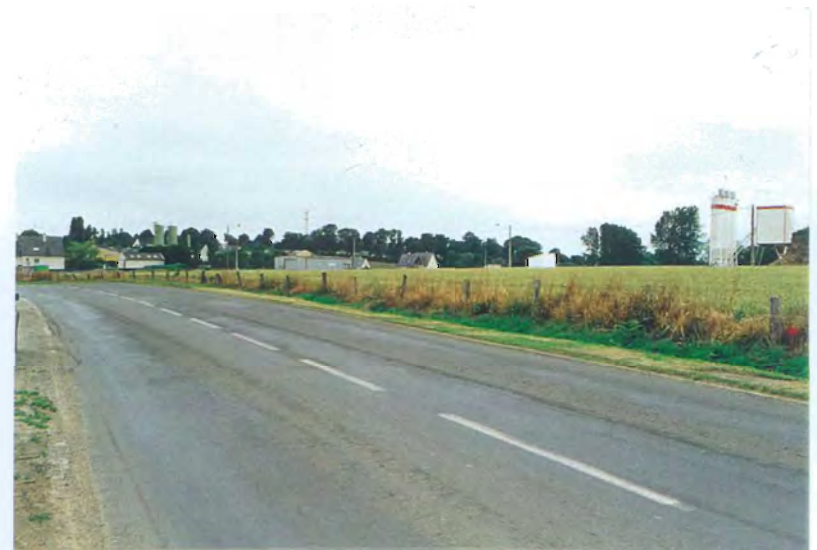
Une intégration insuffisante pour des constructions aux vocations disparates (Nord Est).
