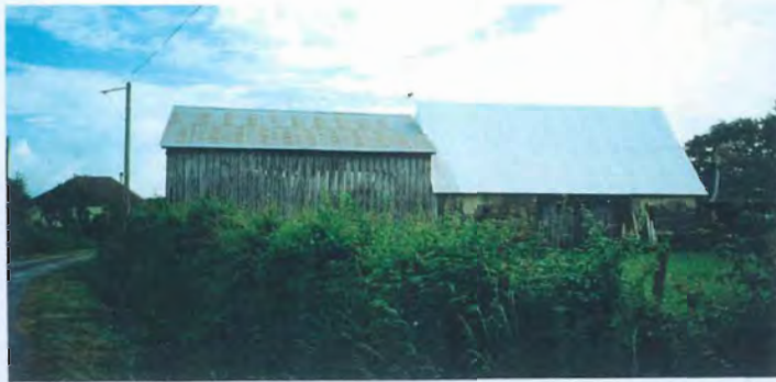
Deux hangars agricoles anciens : l'un en bois, l'autre en terre et bois, ils sont des exemples de l'architecture rurale locale. La substitution des ardoises par des matériaux réfléchissants a un impact non négligeable sur le paysage.
