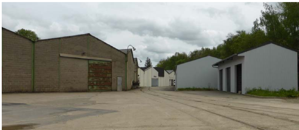
Des entreprises de réhabilitation et de requalification de l'existant sont engagées et se mêlent aux anciens bâtiments vieillissants (Port-Brillet - 2015)
