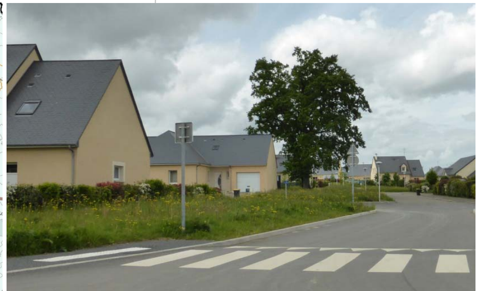
Les extensions urbaines des communes sous influence lavalloise se matérialisent par la prolifération de l'architecture pavillonnaire (Louverné - 2015)
