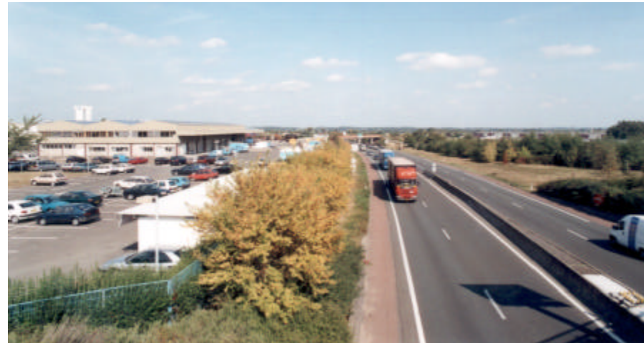
Lisière Est, agglomération limitée par la rocade Est Paris/Cholet
