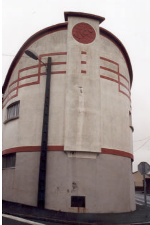
Ancien bâtiment industriel dans le bourg de Trémentines
