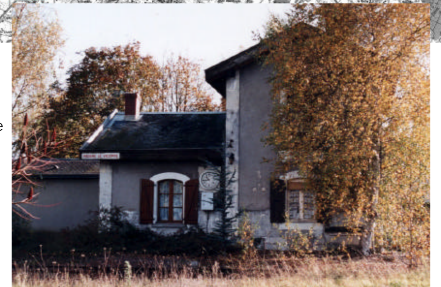
Ancienne Maison de Garde Barrière le long d'une voie désaffectée Secteur de Baugé
