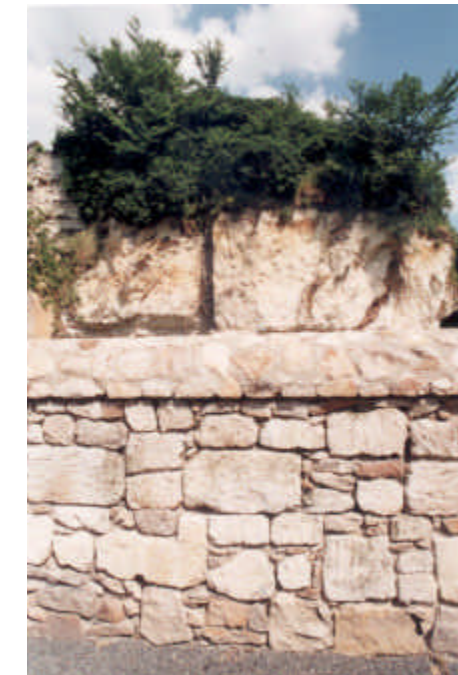
Vestige de l'oppidum de Chenehutte-Les-Tuffeaux (une partie des murailles)
