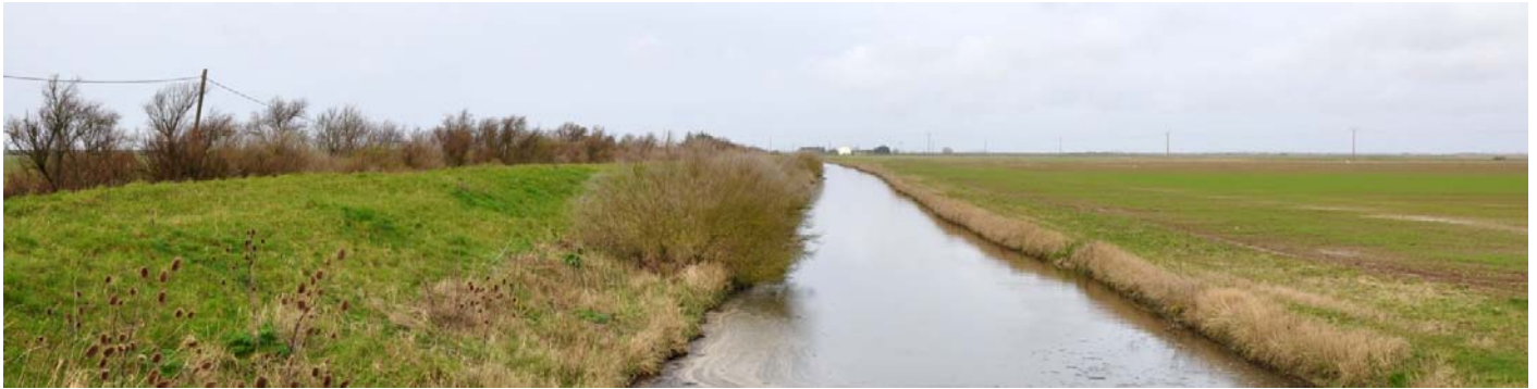
UP49-20-13 Digue (bot) et fossé (contre-bot) protégeant des crues le marais desséché (Champagné-les-Marais)
