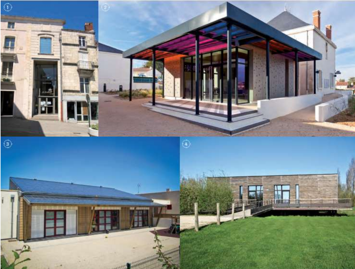
1 : Médiathèque Jim-Dandurand, réhabilitation, architecte : Bruno Donzet, 2003, Fontenay-le-Comte. / 2 : Mairie de Sérigné, réhabilitation et extension, architecte : Cabinet Groleau-Pochon, 2012 / 3 : Centre intergénérationnel, architectes : Agence Boisson-Burban, 2009, Mouzeuil-Saint-Martin 4 : Accueil de la Réserve biologique départementale de Nalliers-Mouzeuil-Saint-Martin, conception : Conseil Général de la Vendée, 2005, Nalliers-Mouzeuil-Saint-Martin.
