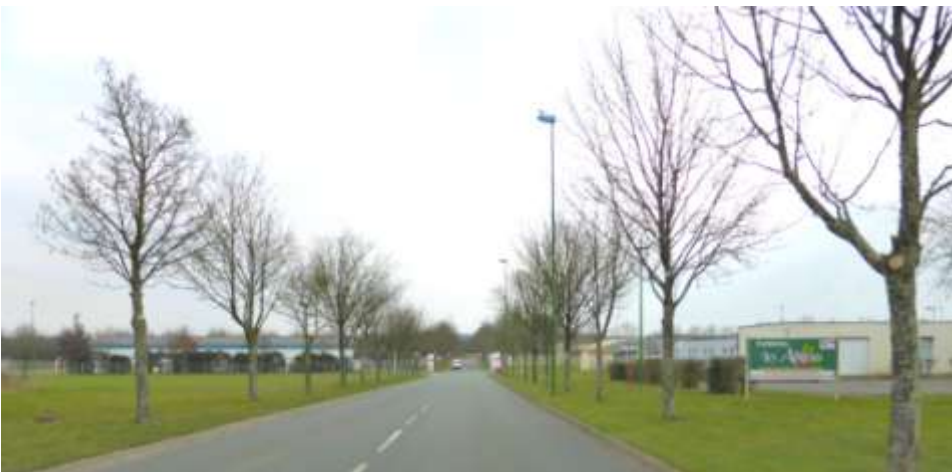
UP48-50-02 Les alignements d'arbres bordant la voie contribuent à structurer qualitativement le paysage de la zone d'activités (Sainte-Hermine)
