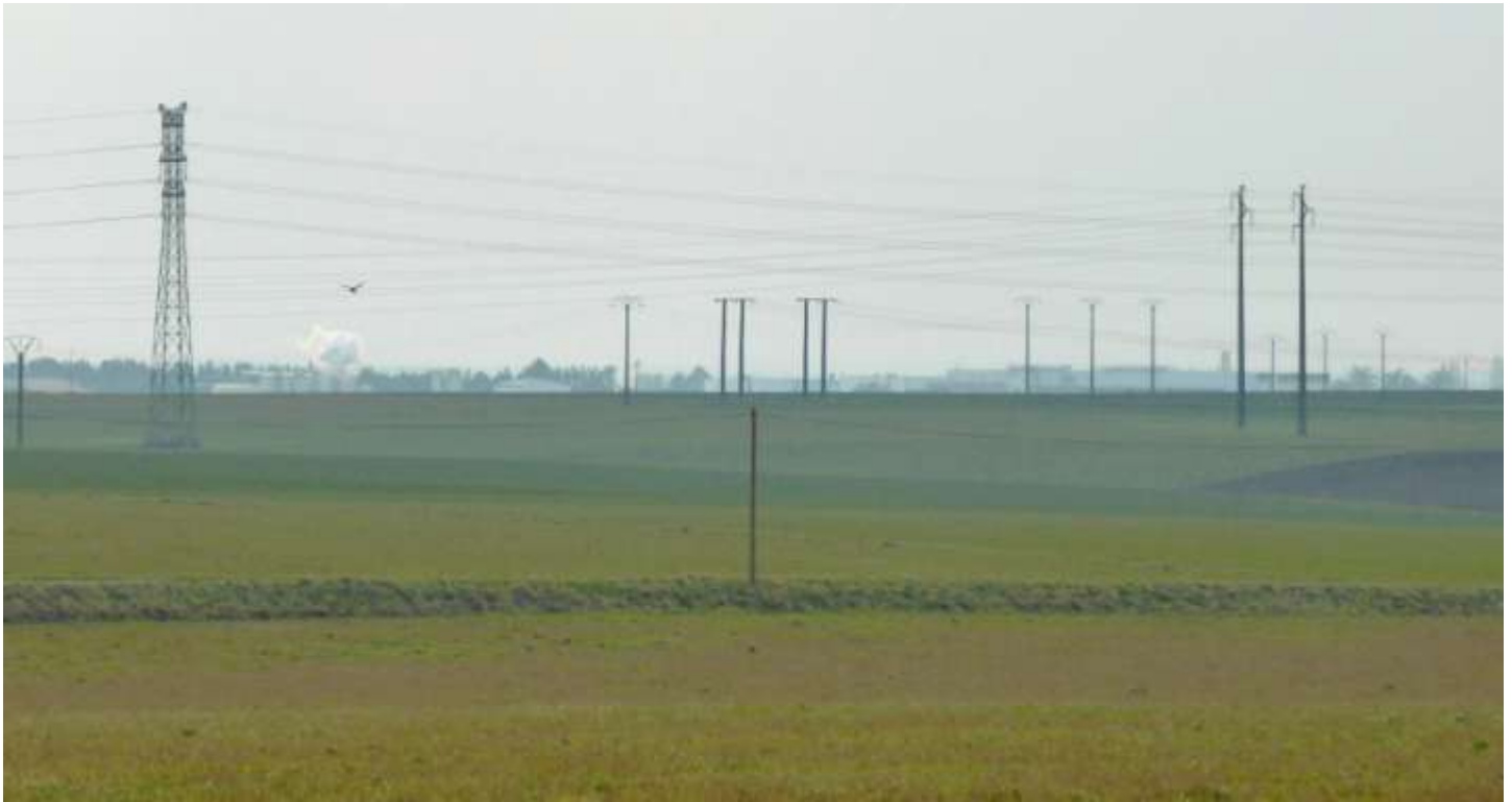
UP48-40-09 Vue vers le sud depuis la D745 (sortie est de Fontanay-le-Comte) : Les infrastructures liées au transport de l'électricité sont très visibles dans le cadre des paysages de champs ouverts
