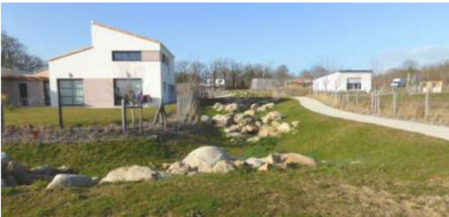
UP47-50-09 Le cadre des opérations d'ensemble de type écoquartiers permet de mener une réflexion sur la relation paysagère entre l'urbain et le rural (Ecoquartier de la Marronnière à Le Bourg-sous-la-Roche – 2015)
