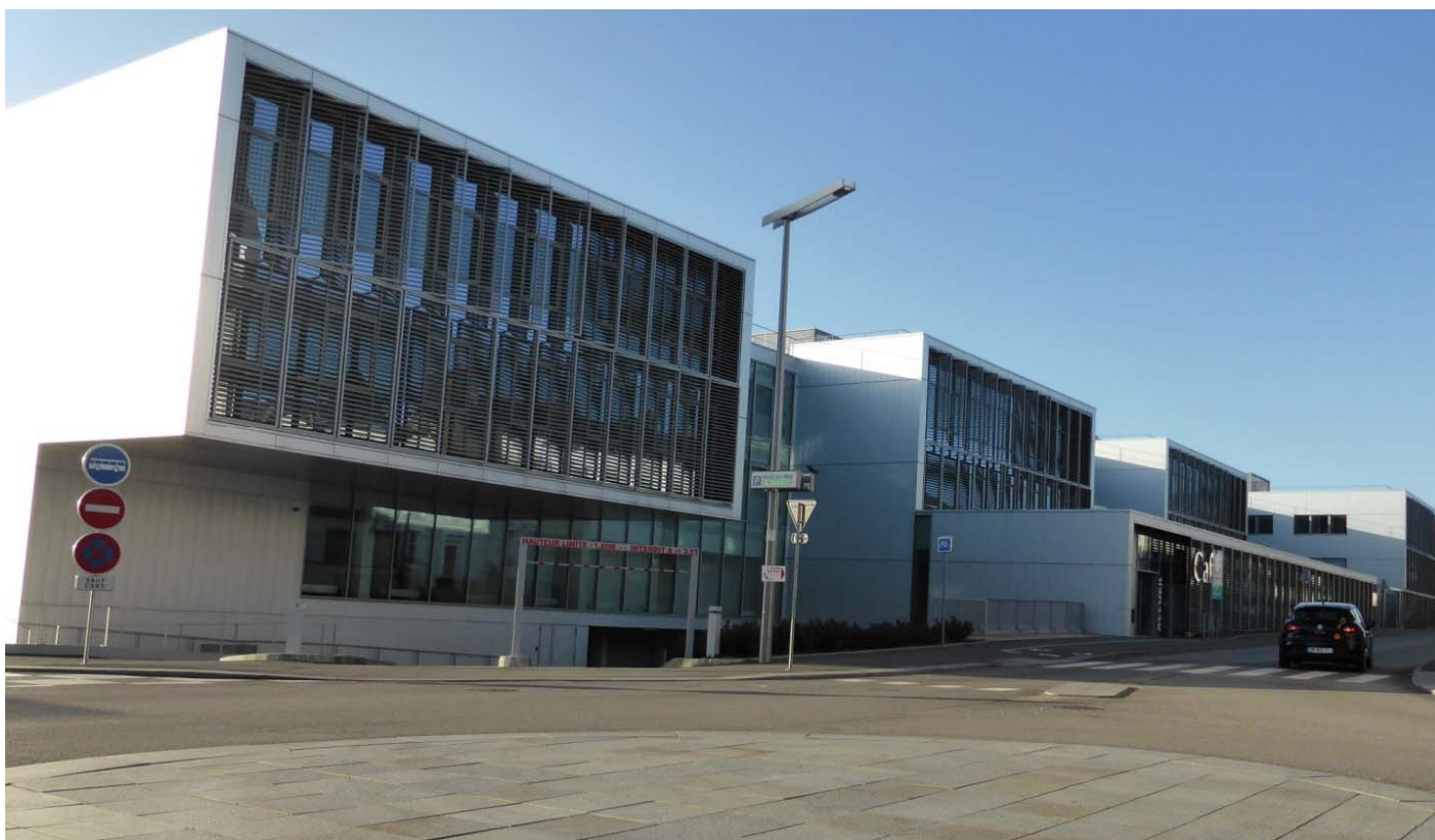
UP47-50-02 Les entreprises de renouvellement urbain en cours sont notamment visibles à travers les constructions de bureaux dans le quartier de la gare (La Roche-sur-Yon – 2015)
