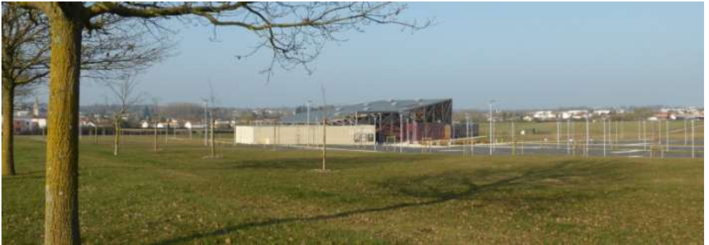
UP45-40-02 Les axes de contournement de bourg et les giratoires associés créent de nouveaux lieux stratégiques pour l'implantation des bâtiments d'activités et des équipements publics structurants (Chantonnay – 2015)
