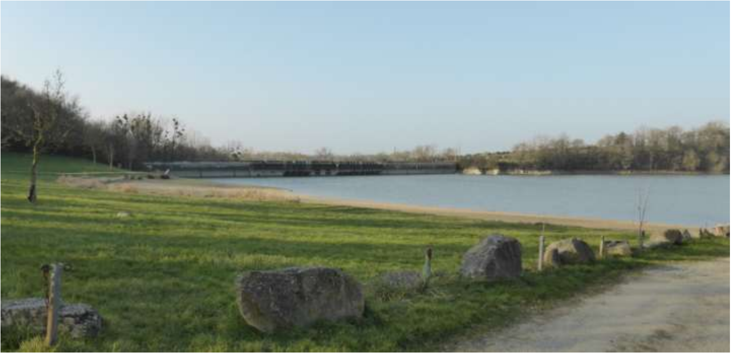
UP45-40-04 Retenue d'eau du Grand Lay dans le secteur de Rochereau (Bazoges-en-Pareds – 2015)
