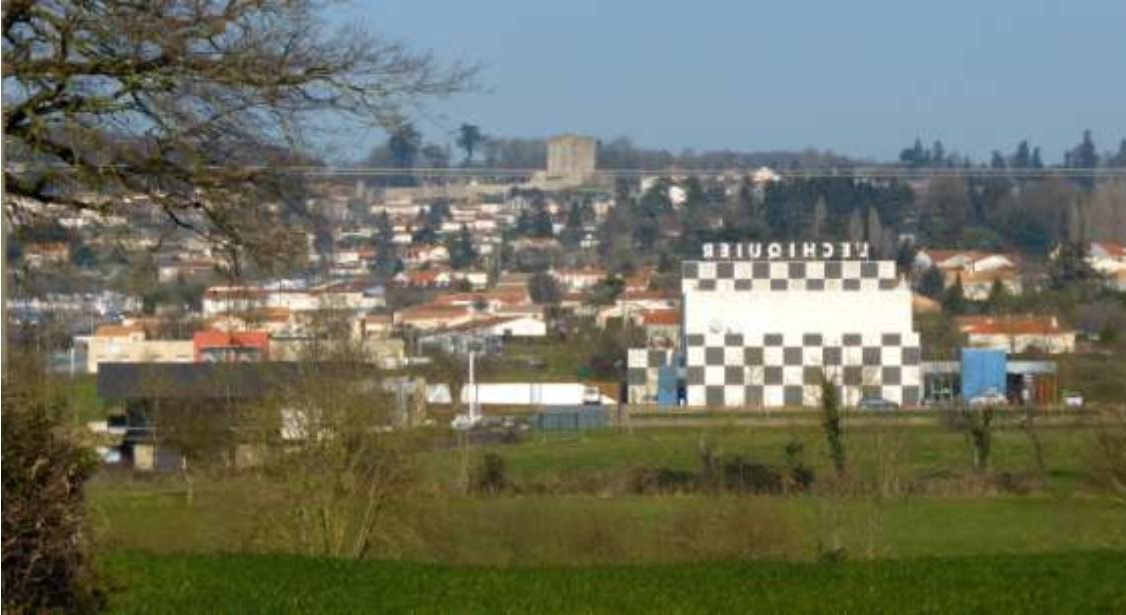
UP44-50-03 Certains éléments bâtis peuvent porter atteinte à la qualité du panorama sur le centre ancien (Pouzauges – 2015)
