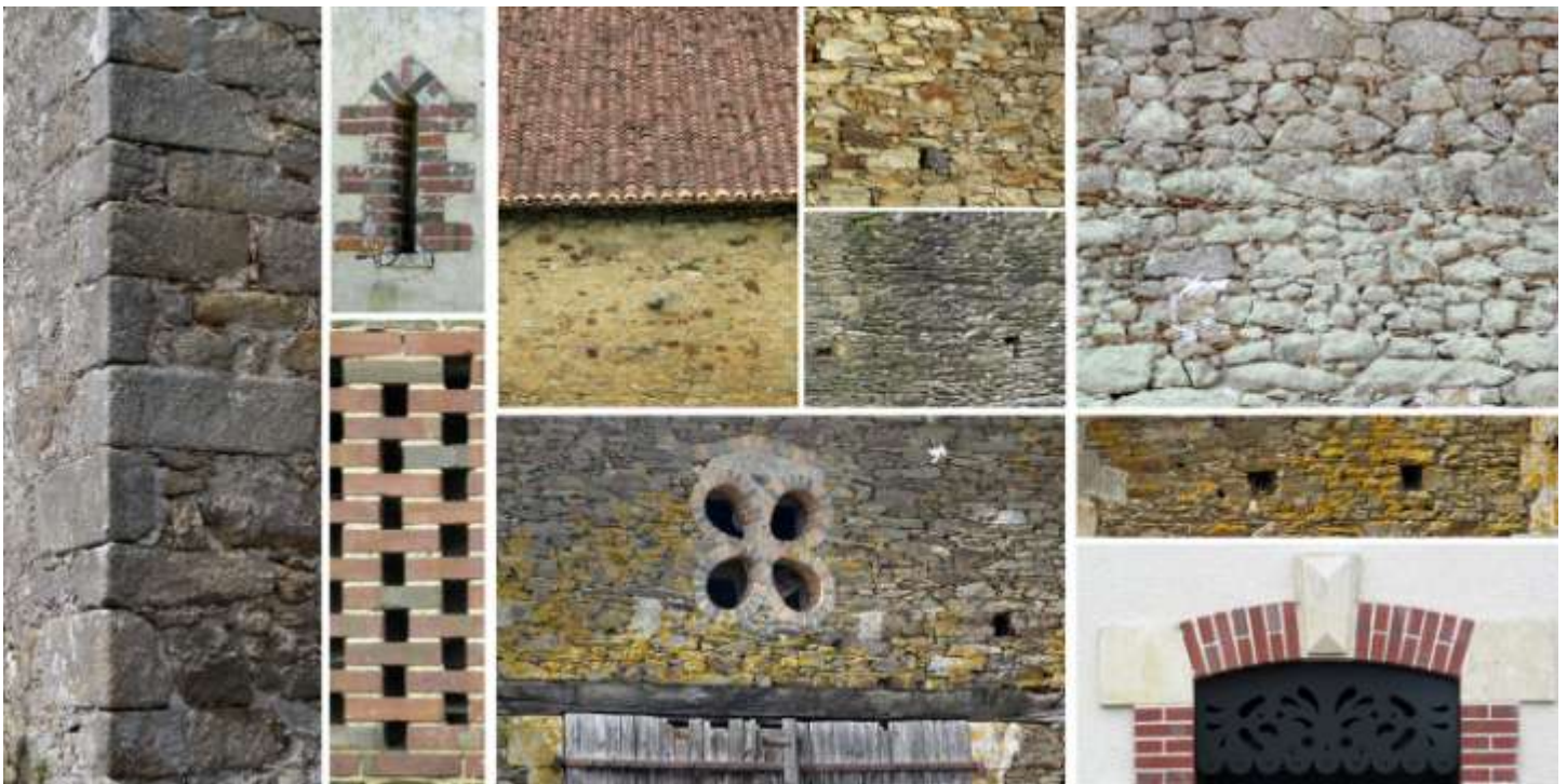
UP44-20-19 Palette de matériaux de l'architecture du nord Vendée : des matériaux de construction traditionnels aux couleurs chaudes (schistes, granits, gneiss, tuile et brique)
