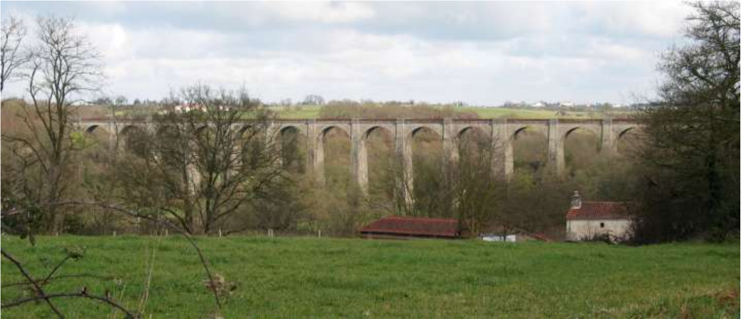
UP44-20-33 Viaduc de la Barbinière, un ouvrage spectaculaire dans la vallée de la Sèvre Nantaise (Saint-Laurent-sur-Sèvre)
