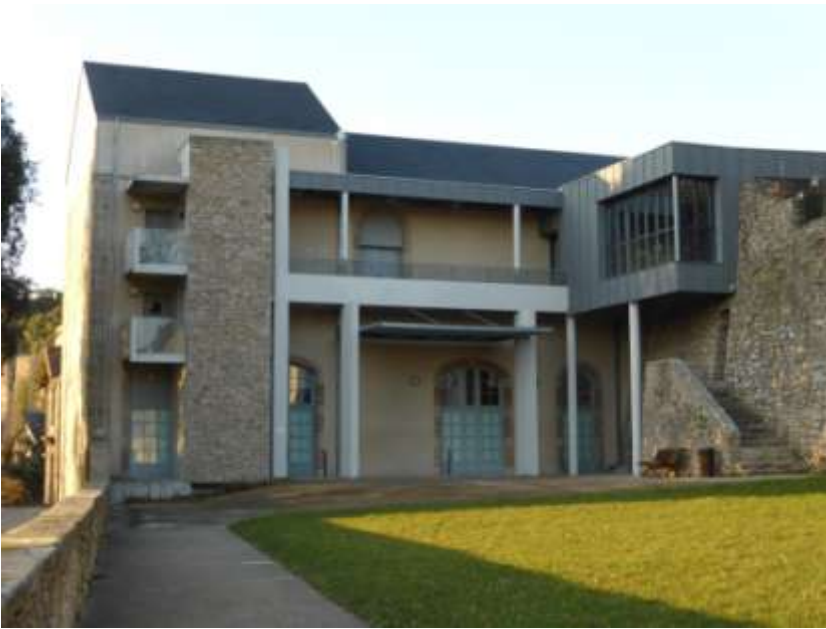
UP44-50-08 Exemple d'intervention architecturale contemporaine en vue de la requalification du bâti ancien (Mortagne-sur-Sèvre – 2015)
