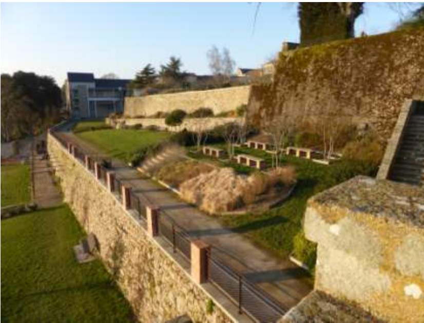
UP44-50-09 Certaines interventions contemporaines fournissent des bons exemples de revalorisation du patrimoine ancien (Mortagne-sur-Sèvre – 2015)
