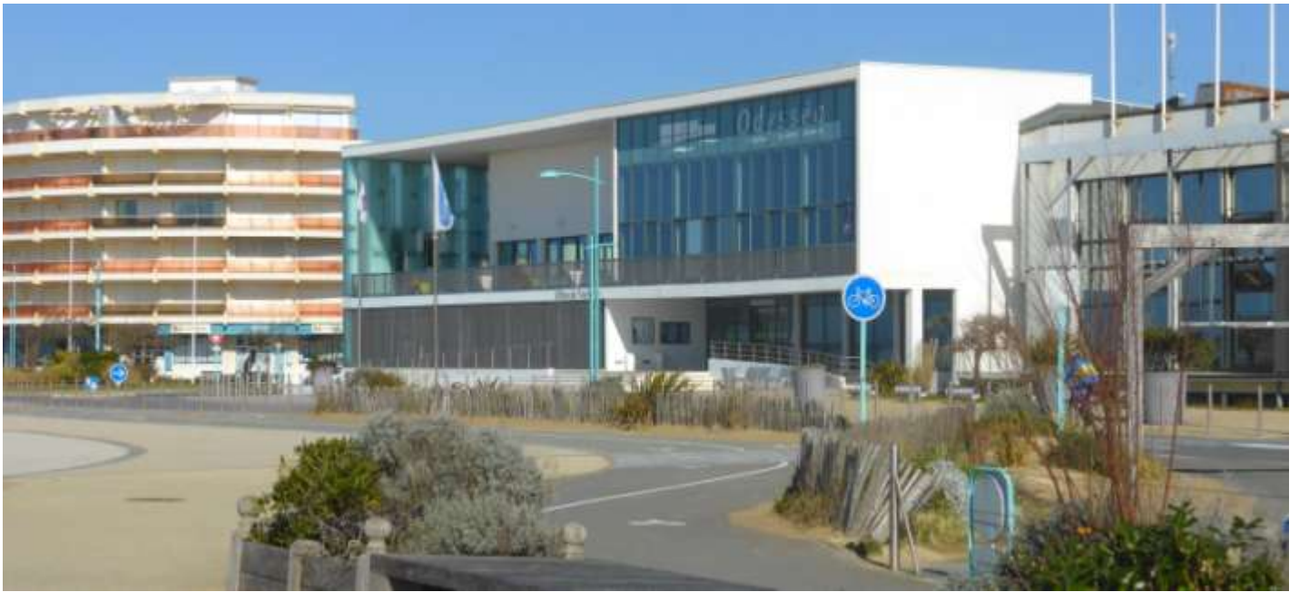
UP42-40-09 Le Palais des Congrès Odyssea aménagé en 2009, donne une nouvelle modernité au front de mer de Saint-Jean-de-Monts (Saint-Jean-de-Monts – 2015)
