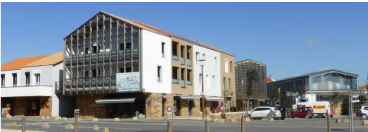
UP42-50-02 Requalification des espaces publics et du bâti ancien dans le quartier des Halles de Brétignolles-sur-Mer (Brétignolles-sur-Mer)
