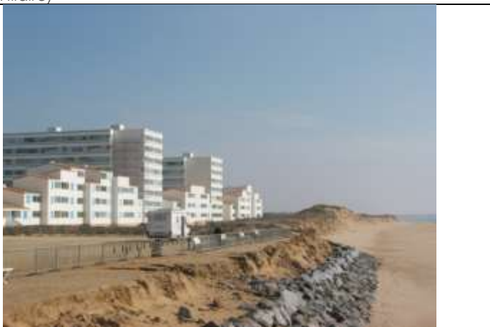
4 Un front urbain et des ouvrages de protection qui artificialisent la côte dunaire (St-Hilaire-de-Riez)
