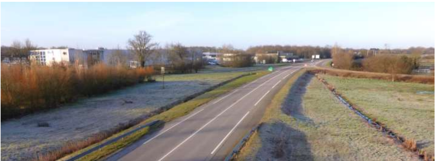
UP40-40-02 L'échangeur de la RD 751 constitue un point stratégique pour le développement d'une zone d'activités (Arthon-en-Retz – 2015)
