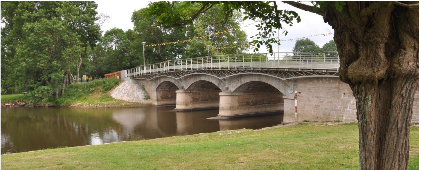
UP39-15- Pont de fer sur la Boulogne - Saint-Philbert-de-Grand-Lieu
