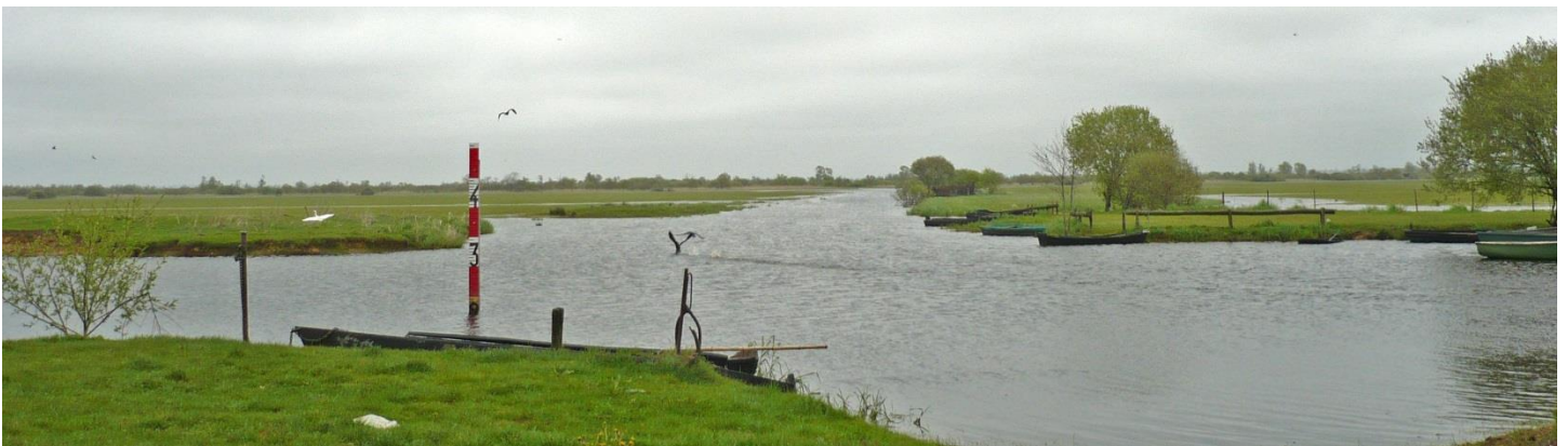
UP39-20-08 Canal joignant le lac à St Lumine de Coutais
