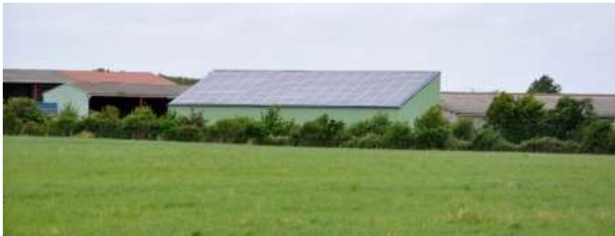
37-40-05 Un hangar monumental à toiture solaire monopente qui se distingue dans le bocage
