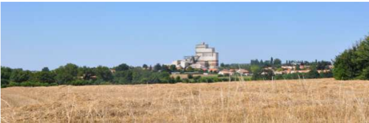
37-20-24 Un bâti industriel monumental qui signale le bourg de Saint Fulgent sur l'horizon
