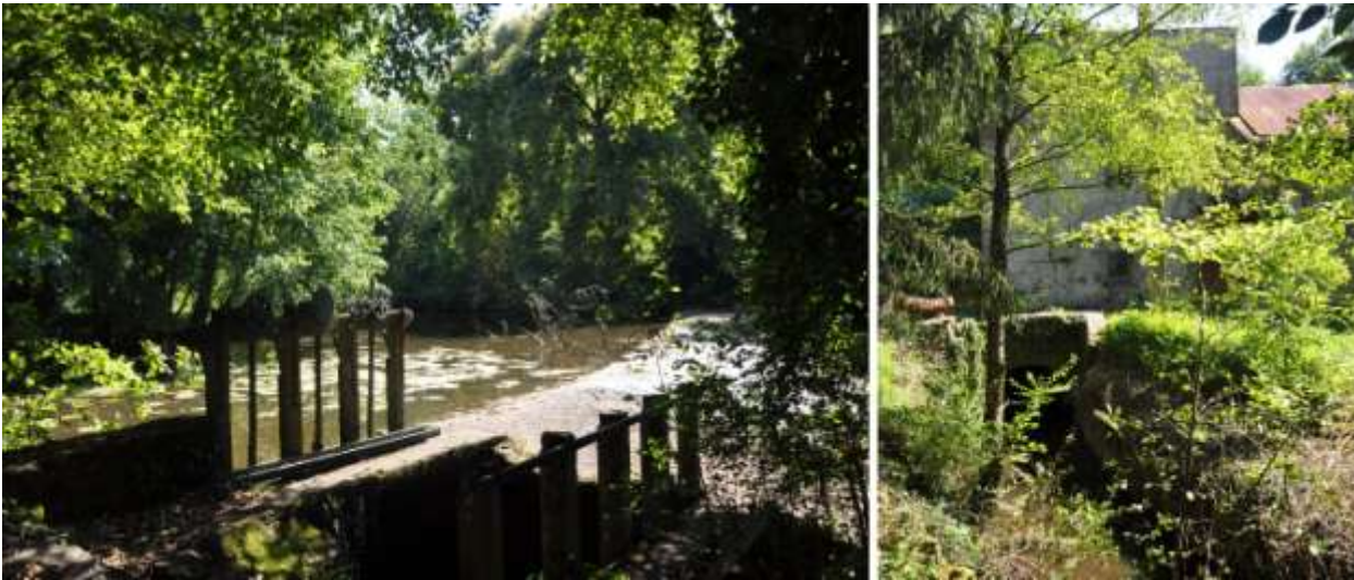
37-20-06 Chaussée et moulin à eau dans la vallée de la Grande Maine (La-Boissière-de-Montaigu)
