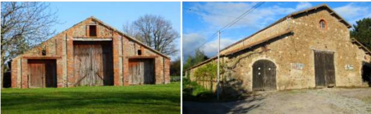
37-20-29 Grange simple et grange à nef typique des bocages vendéens et maugeois
