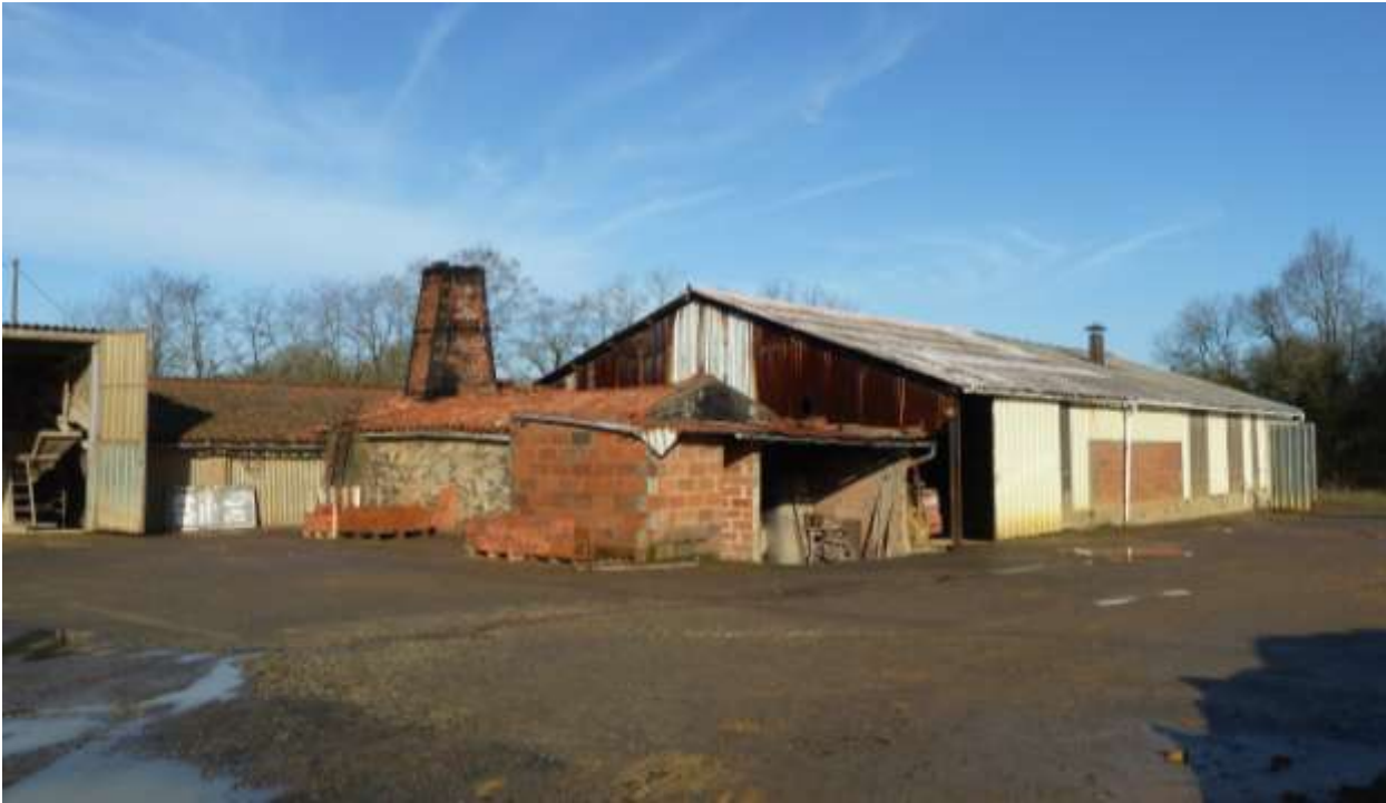
37-20-35 Four de briqueterie à Tillières
