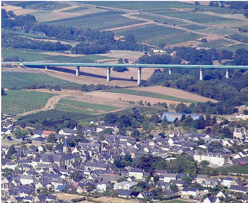
UP36-40-21 L'aménagement de l'A87 a entraîné la construction d'un viaduc surplombant le Layon à proximité du bourg de Beaulieu-sur-Layon (source : J.-L. POURCHER, R. KRIM, Beaulieu vu du ciel. ( http://www.beaulieu-sur-layon.com ))
