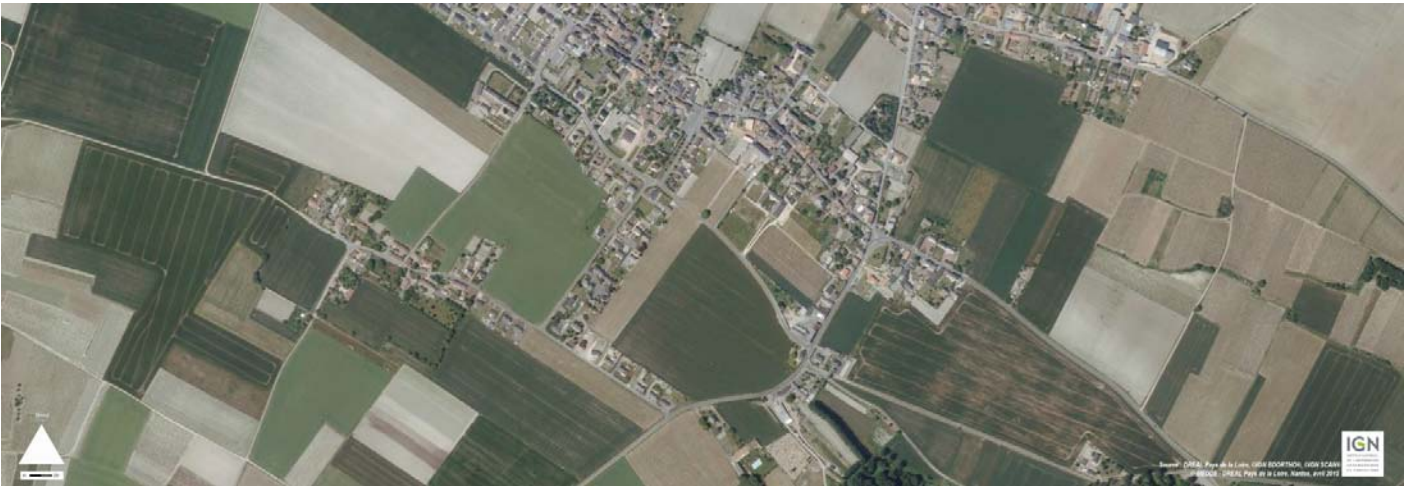
UP36-40-19 Dans le secteur de Vaudelnay, la diffusion de l'urbanisation menace d'enclaver les terres agricoles au sud du bourg (2013)
