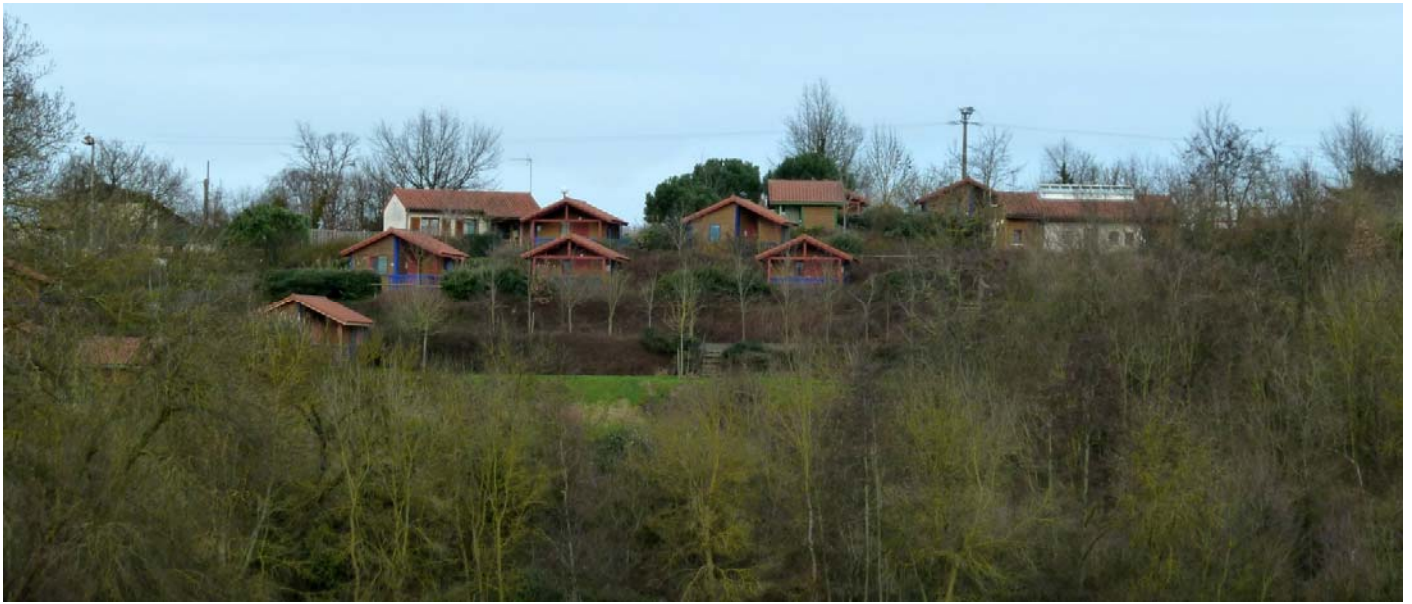
UP36-50-02 L'aménagement de petits chalets dans un camping apparaît en décalage avec l'identité architecturale de l'unité (Saint-Georges-sur-Layon)
