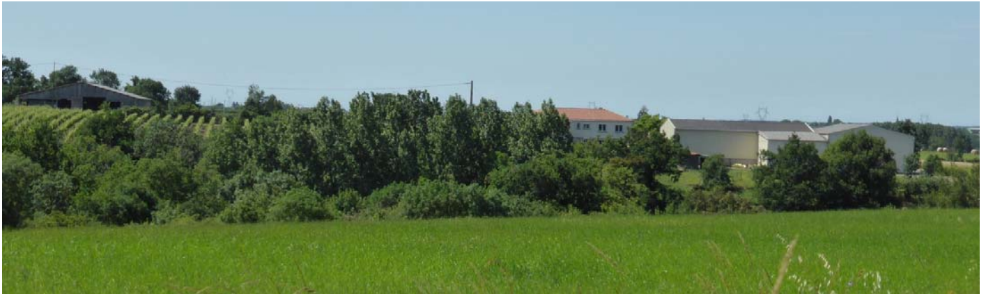
UP36-50-04 Le développement des bâtiments à caractère industriel en lien avec l'activité viticole crée de nouveaux repères dans le paysage. Le caractère imposant de ces nouveaux bâtiments rend le rapport d'échelle traditionnel entre bâti et trame végétale moins harmonieux. (Aubigné-sur-Layon, 2015)
