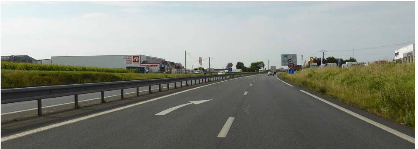
UP36-40-32 A Brissac, l'aménagement de la D748 en contournement est de la ville a favorisé le développement des activités économiques (Brissac-Quincé - 2015)
