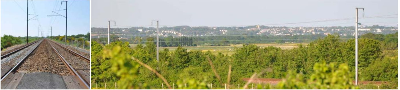
UP32-10-1 Levée de la voie ferrée marquant une rupture dans le paysage (Donges)
