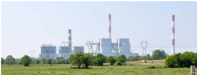
UP32-20-19 Centrale électrique de Cordemais un repère au cœur des paysages de la Loire estuarienne (Cordemais)
