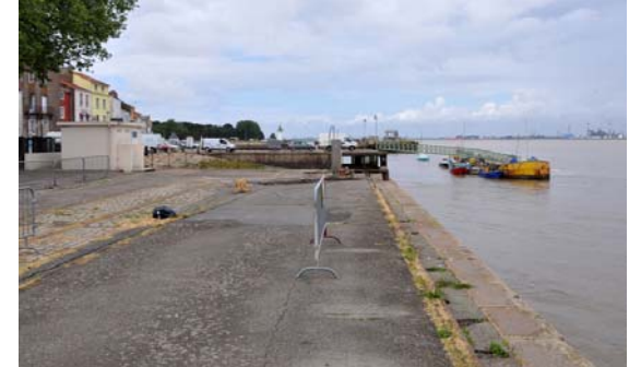
6. Paimboeuf un port patrimonial qui marquait l'entrée dans l'estuaire et qui fait face aujourd'hui aux infrastructures industrialo-portuaires en rive nord (Paimboeuf)
