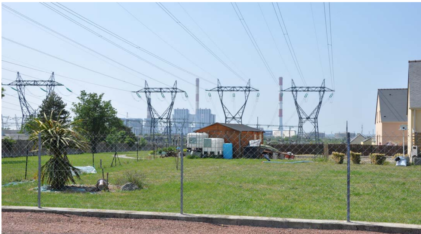
UP32-40-01 Le réseau des lignes THT a pleinement influé sur l'évolution du paysage urbain de Cordemais, à la fois à travers sa présence marquante dans le paysage mais aussi en tant que limite au développement urbain vers l'est. (Cordemais)
