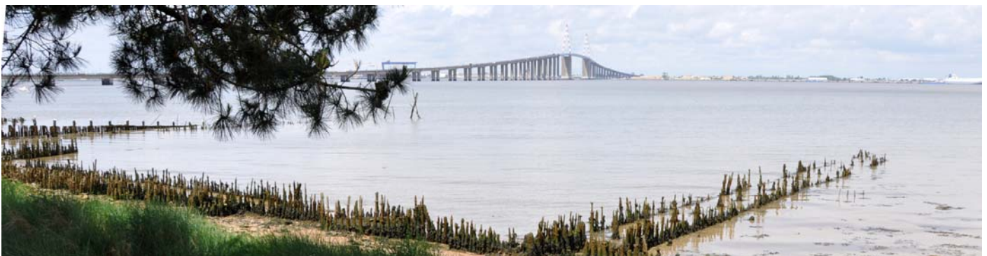
UP32-10-4 Pont monumental de Saint Nazaire, porte entre la Loire et l'océan Atlantique (Saint-Brévin-les-Pins)
