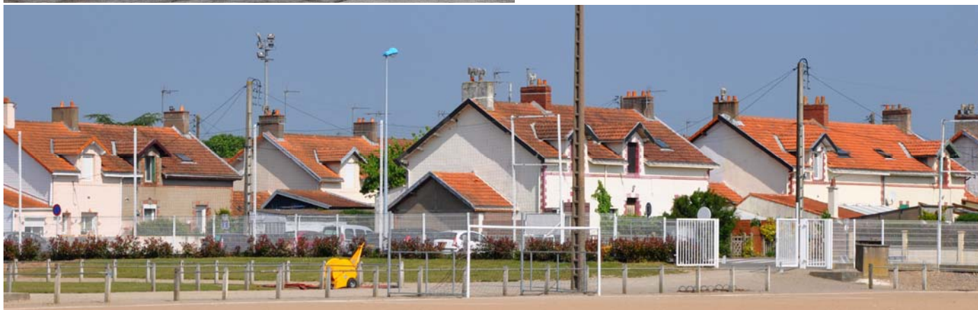
UP32-20-13 Urbanisme régulier d'un quartier ouvrier à l'habitat répétitif (Couëron)
