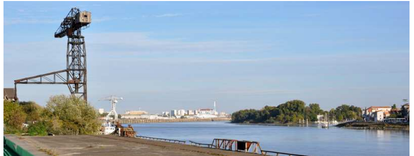
UP31-31-10UN paysage industriel rivulaire ponctué des grues qui introduit les paysages de l'estuaire (Nantes)
