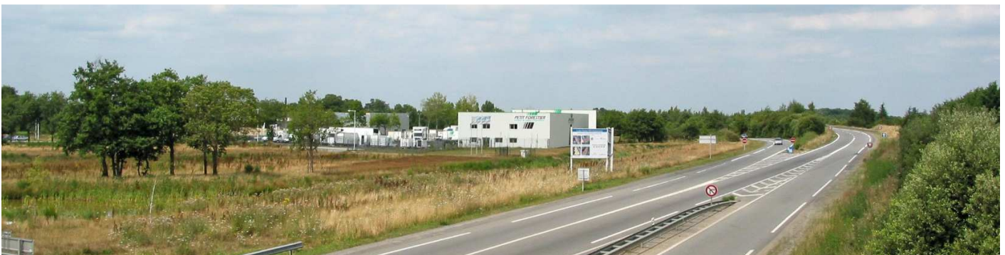
UP31-34-06 Des infrastructures portent leur propre paysage et créent des ruptures dans l'espace périurbain (Les Sorinières)
