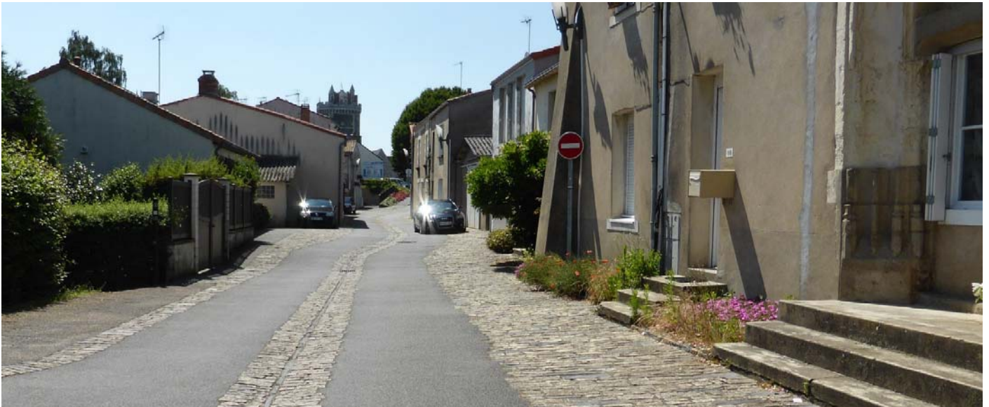
UP30-50-La mise en valeur du paysage urbain ancien, et notamment des fronts urbains, passe également par la requalification des voies et des espaces publics (Oudon)
