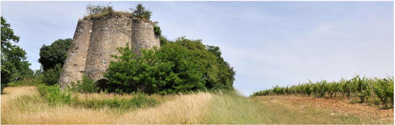
PSP03 Four à chaux constituant un repère monumental dans le paysage viticole du Layon (Saint Aubin-de-Luigné)
