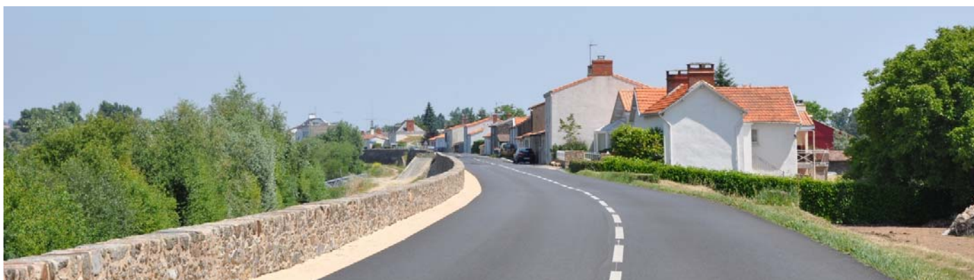
UP30-20-36 La levée habitée de la Divatte qui isole le polder fluvial maraîcher (à droite) des inondations de la Loire (à gauche) (La Chapelle-Basse-Mer)
