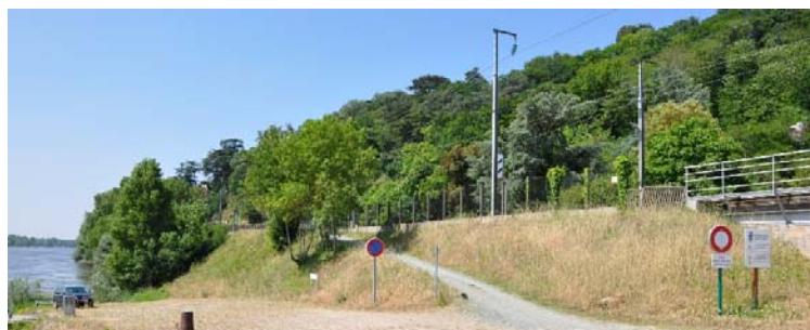
UP30-20-34 La voie ferrée, train d'union urbain mais rupture paysagère en pied de coteau nord de la Loire (Le Cellier)
