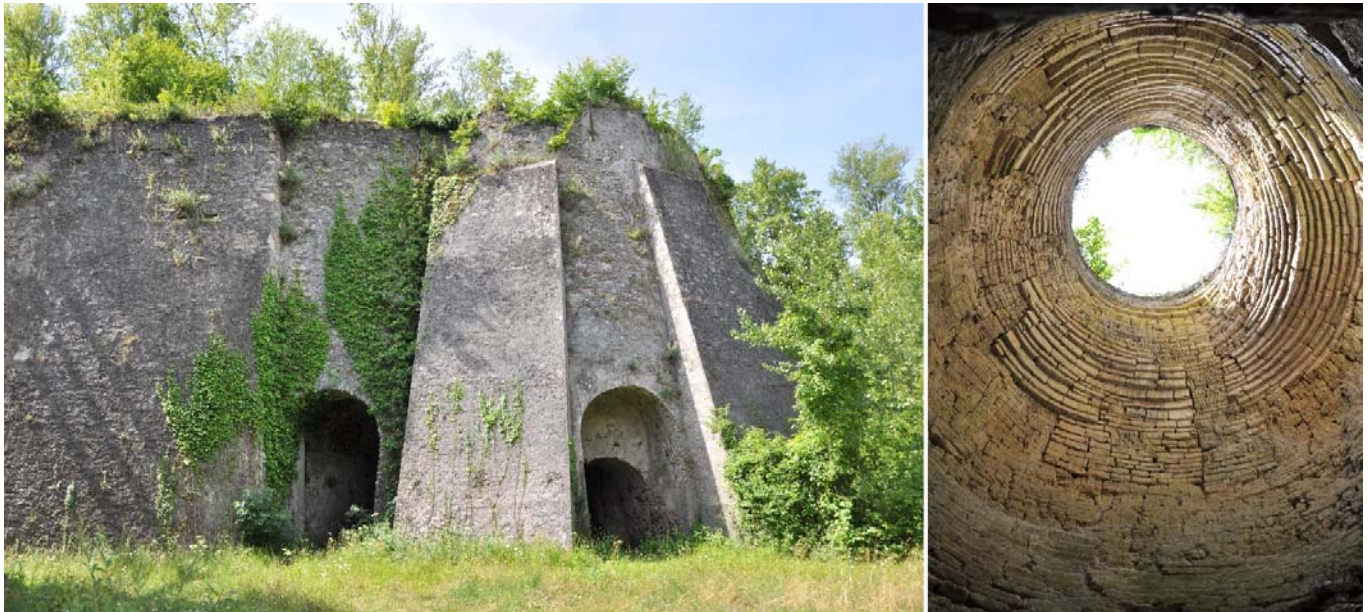
PSP01 Four à chaux monumental en pied de coteau de la Loire et vue intérieure de la cheminée (Montjean-sur-Loire)
