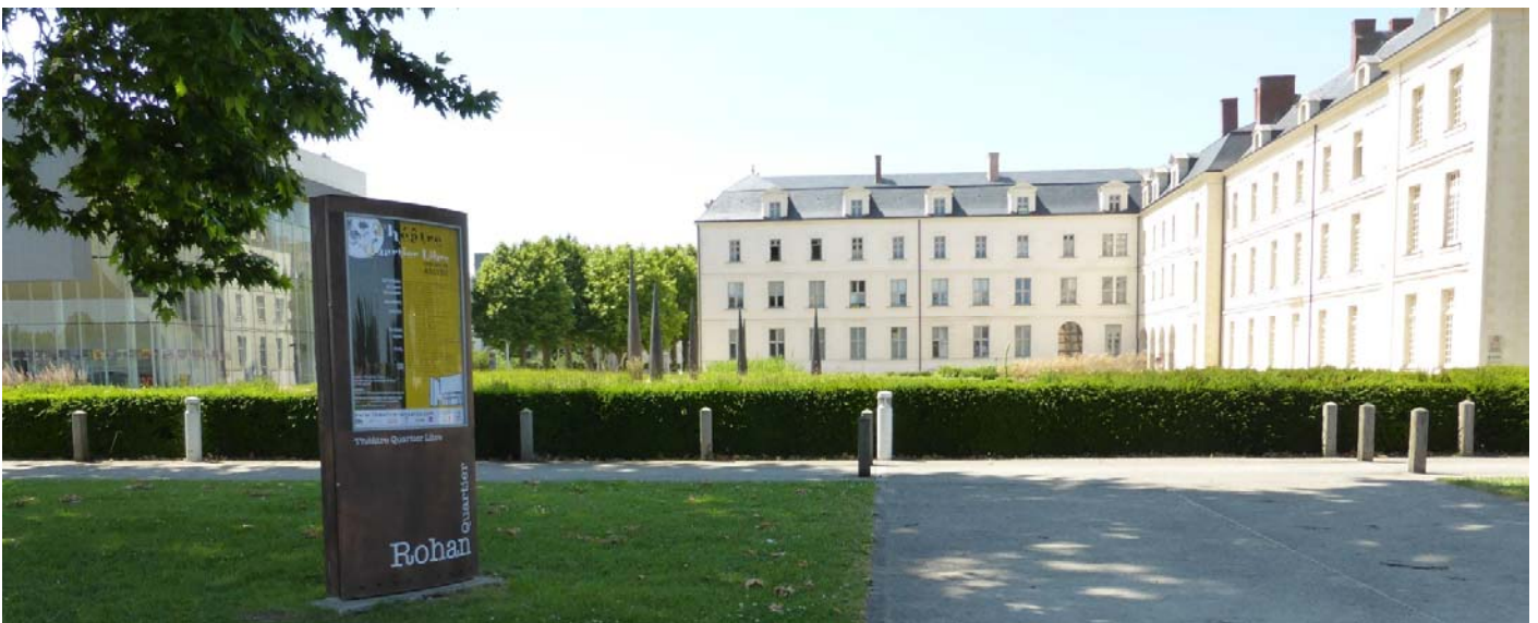
UP30-40-XXX, A Ancenis, des opérations de requalification du patrimoine existant ont été menées durant ces dernières années (Ancenis - 2015)
