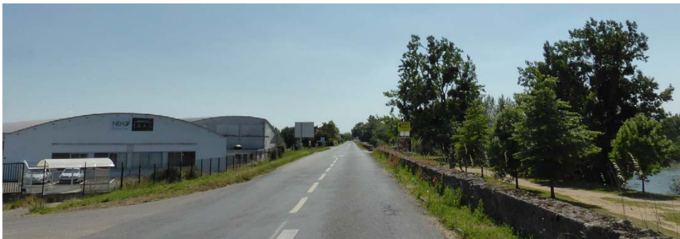
UP30-40-XXX, Le long de la levée de la Divatte, un effet de continuum urbain s'est développé avec la présence d'un habitat ancien, de bâtiments d'activités et de serres maraîchères (La Chapelle-Basse-Mer - 2015)
