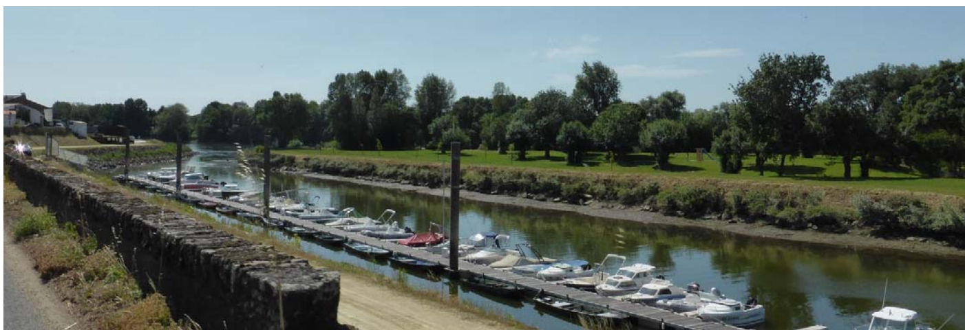
UP30-40-XXX, Entre parcours de golf, port de plaisance et aménagement d'une piste cyclable : les bords de Loire le long de la levée de La Divatte accueillent de plus en plus d'équipement à vocation récréative (La Chapelle-Basse-Mer - 2015)
