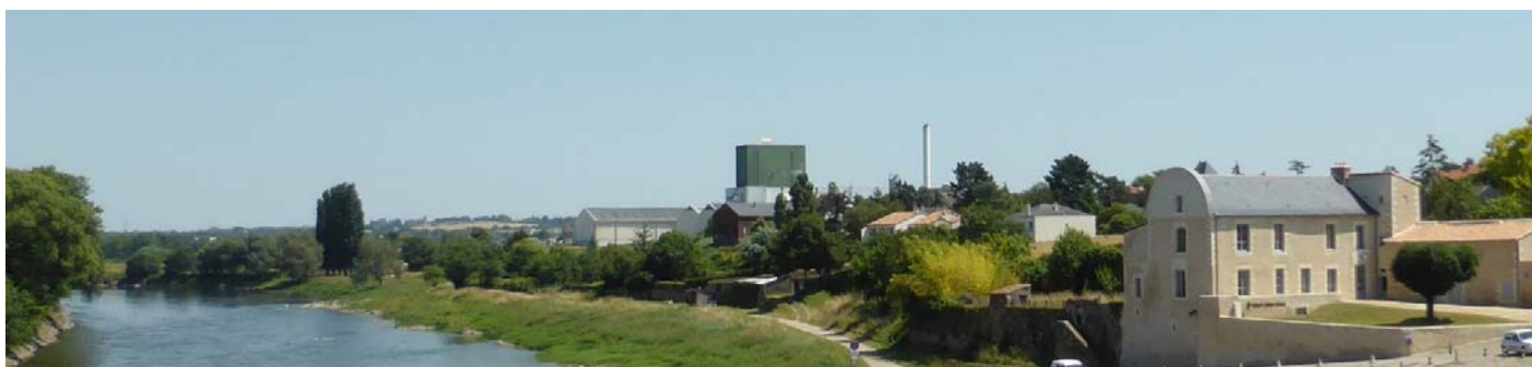
UP30-50-L'intégration des bâtiments d'activités constitue un enjeu important au vu de la sensibilité paysagère des paysages de la Loire (Saint-Florent-le-Vieil)
