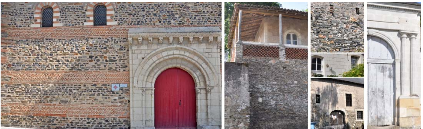
UP30-20-05 Diversité des roches mises en œuvre dans l'architecture avec le calcaire comme fil conducteur ligérien
