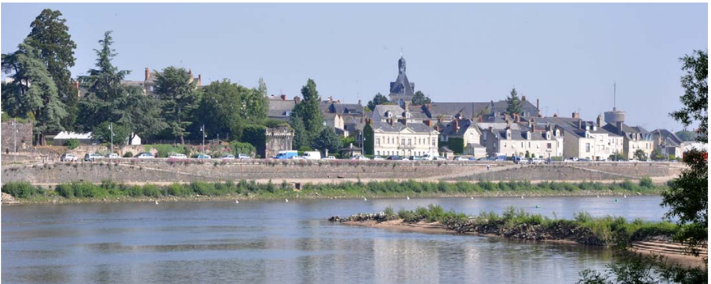
UP30-20-31 Quais et façade urbaine sur la Loire de la vieille ville d'Ancenis (Liré)
