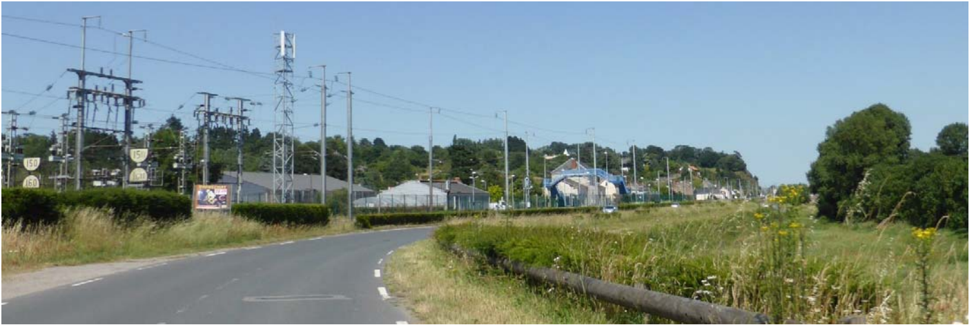
UP30-40-XXX La ligne TGV et les aménagements de gare type passerelle offre un aspect industriel au paysage (Mauves-sur-Loire - 2015)
