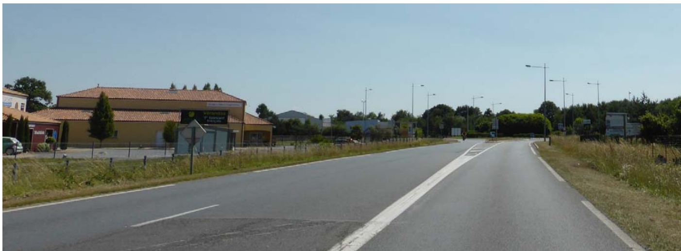
UP30-40-XXX Les abords de la D723 est le support de développement d'activités le long de son tracé (Le Cellier - 2015)
