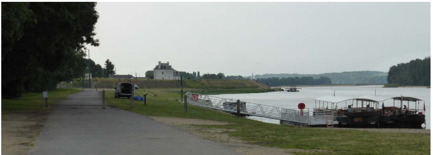
UP29-40-18 L'aménagement de chemins piétons et la présence de péniche guinguette visent à valoriser les berges (La Ménittré - 2015)
