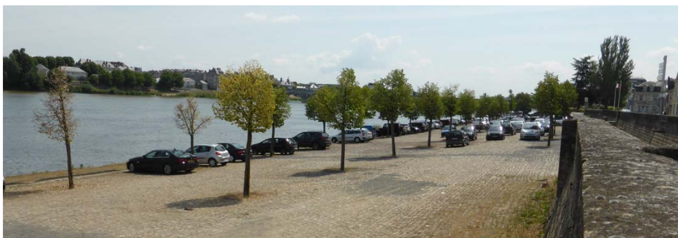
UP29-50-04 Le maintien d'un pavage traditionnel sur les berges ainsi qu'un accompagnement végétal simple permet la création d'une aire de stationnement adaptée au cadre urbain (Saumur)
