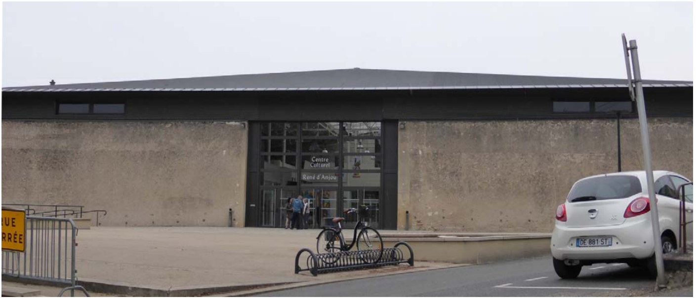
UP28-50-XXX Un des enjeux des paysages urbains consiste en la requalification du patrimoine ancien : ici l'ancienne prison de Baugé est devenu un centre culturel (Baugé-en-Anjou)
