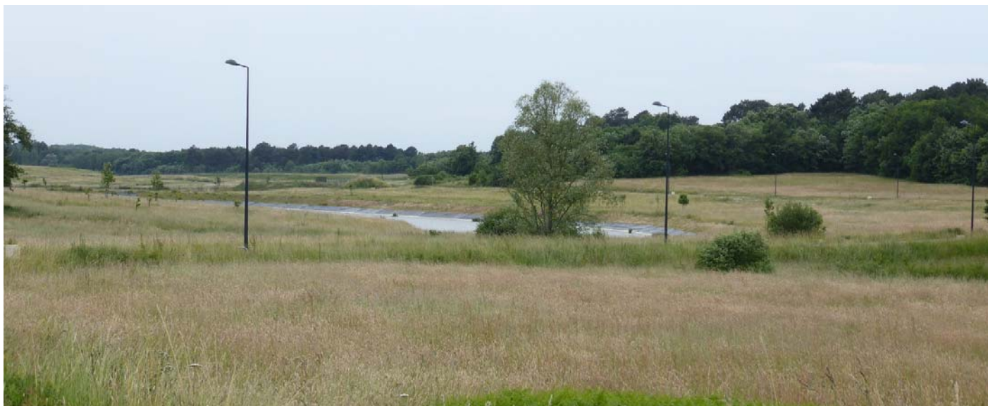
UP28-40-XXX A proximité de l'aéroport d'Angers-Marcé, la mise en place des réseaux (voiries, éclairage...) maille une zone de 40 ha où les bâtiments d'activités sont absents (Marcé - 2015)
