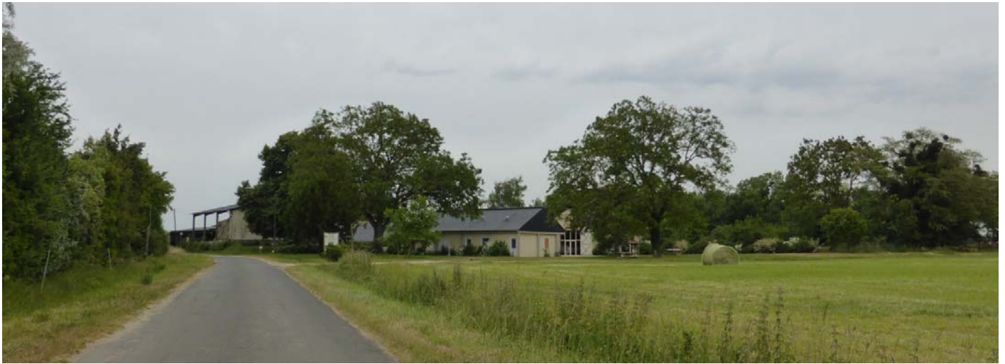
UP28-50-XXX L'intégration des bâtis agricoles constitue un enjeu de l'unité, notamment dans un contexte d'ouverture progressive des paysages (Pontigné)
