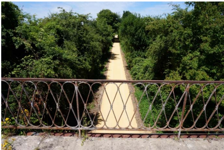
UP28-40-14 Une voie verte entre Baugé et Longué est en cours d'aménagement et empreinte le tracé de l'ancienne voie ferrée (Le Vieil-Baugé - Baugé-en-Anjou - 2015)
