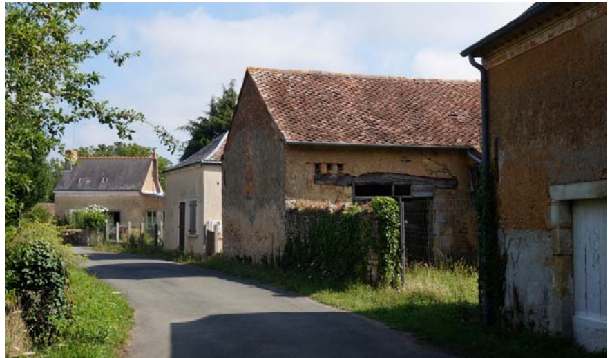
UP28-20-21 Structure urbaine de hameau (Les Rairies)
