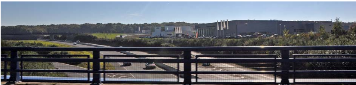
UP27-40-08 Paysage de l'échangeur routier de Beaucouzé avec ses façades commerciales (Beaucouzé - 2014)
