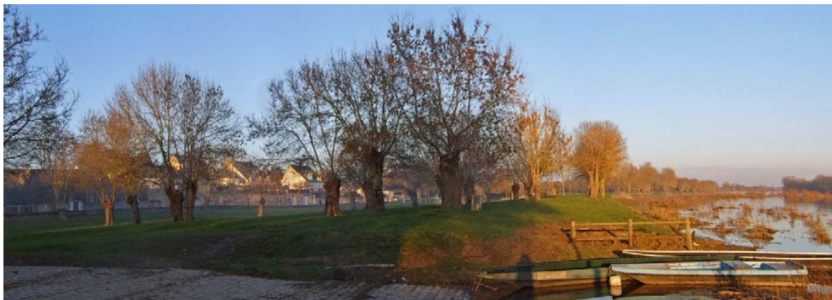
UP27-10-03 Front bâti de Sainte-Gemmes-sur-Loire et ses quais le long de la Loire
