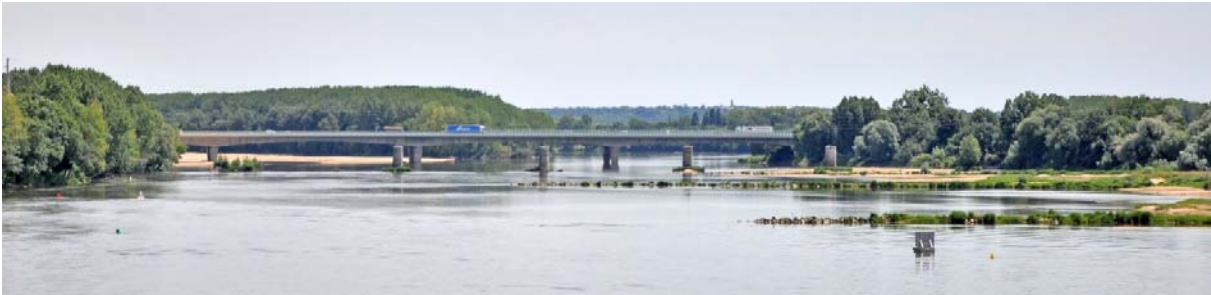
27-10-08 – A87 depuis la traversée urbaine des Ponts-de-Cé
