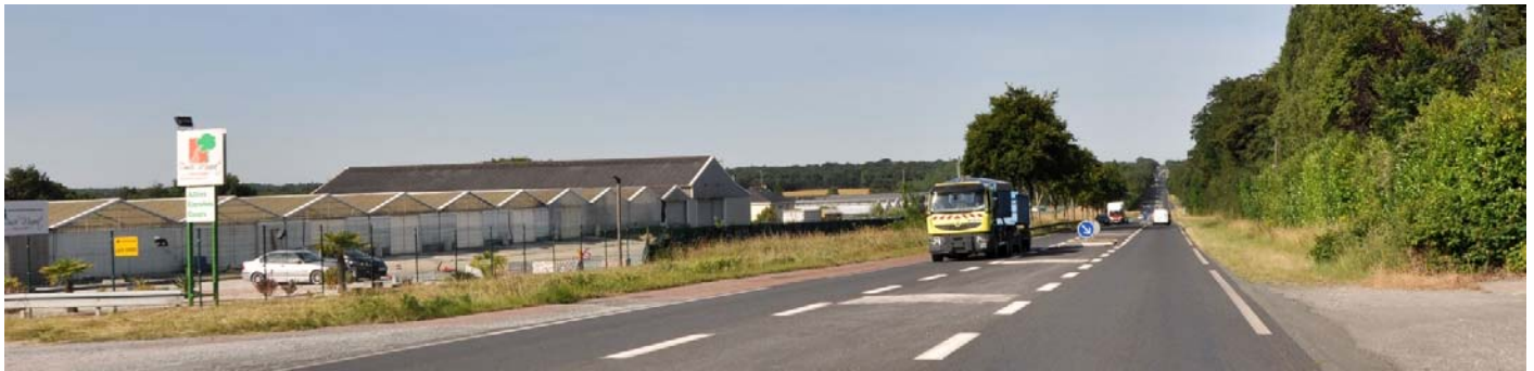
SUP26-30-34 Un axe structurant sur lequel se sont développées des zones d'activités et bourgs (Saint-Jean-de-Linière)
