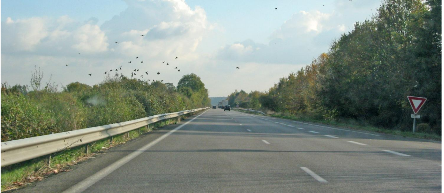
UP23_desc7 Tunnel vert de la route des estuaires (RN137) à hauteur de Derval
