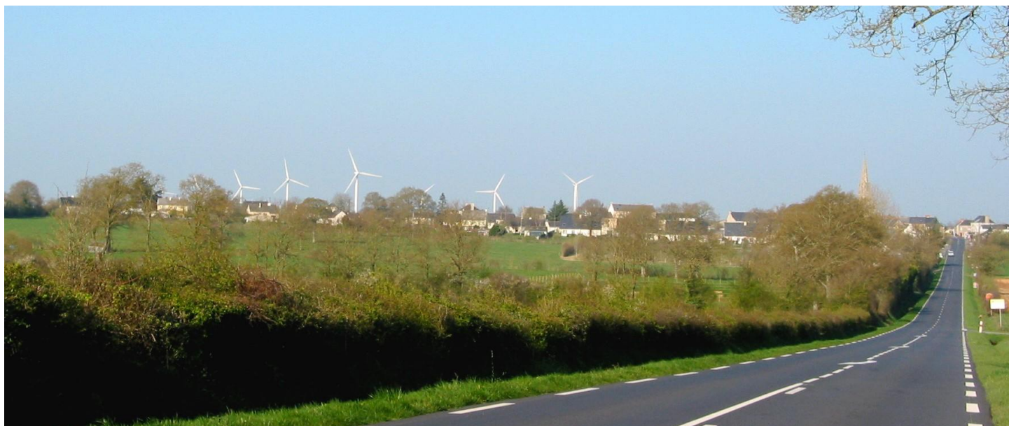
UP23-54-ENJ- Développement éolien vue depuis Lusanger.
