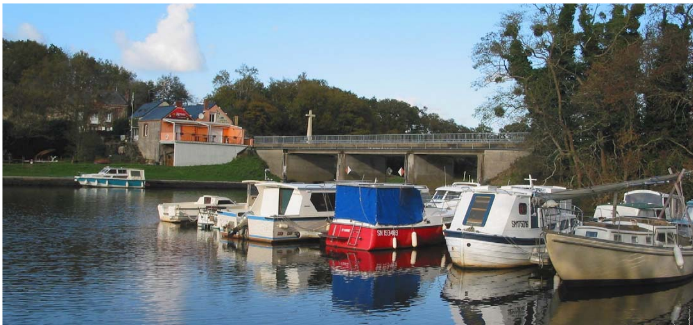
UP23-50-01 Canal de Nantes à Brest, au niveau de Guenrouet.
