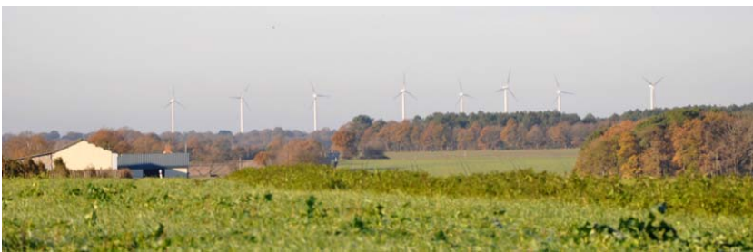
UP23A2 Parc éolien de Derval Lusanger, un repère dans le paysage
