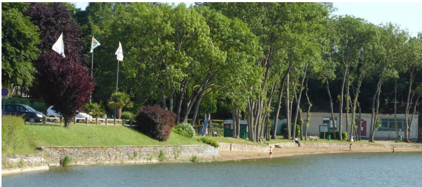
UP22-40-XXX Autour de l'étang de Saint-Aubin, les quais ont été aménagés et des équipements de loisirs développés (Pouancé - 2015)
