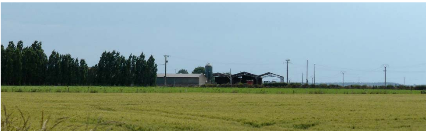
UP22-50-XXX- L'implantation des bâtis agricoles en continuité des haies boisés favorise une intégration paysagère plus qualitative (Pouancé)
