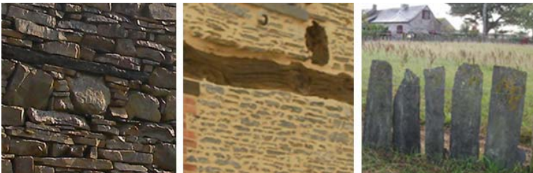
UP20-22-16 Schistes, grès et gneiss mis en œuvre dans l'architecture traditionnelle ou dans les palis de clôture
