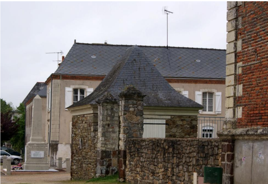
UP21-20-16 expression de l'influence angevine dans l'architecture tuffeau en chaînage d'angle, croupe au niveau des toitures (La Roë)
