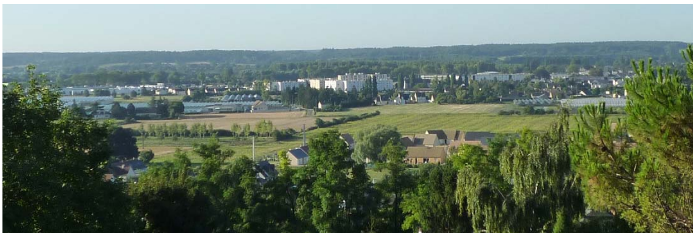
UP19-10-3ter : Depuis les hauteurs de la Flèche (coteau nord) vue longue et dégagée sur la vallée mettant en évidence l'occupation dense de la vallée mais aussi la force du boisement sud qui limite la vallée (La Flèche)
