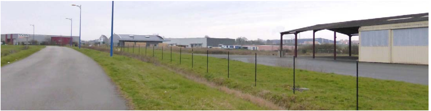
UP19-40-25 – Dans le secteur de Durtal, à proximité de l'A11, certaines zones d'activités connaissent une vacance grandissante des bâtiments d'activités (Durtal – 2015)
