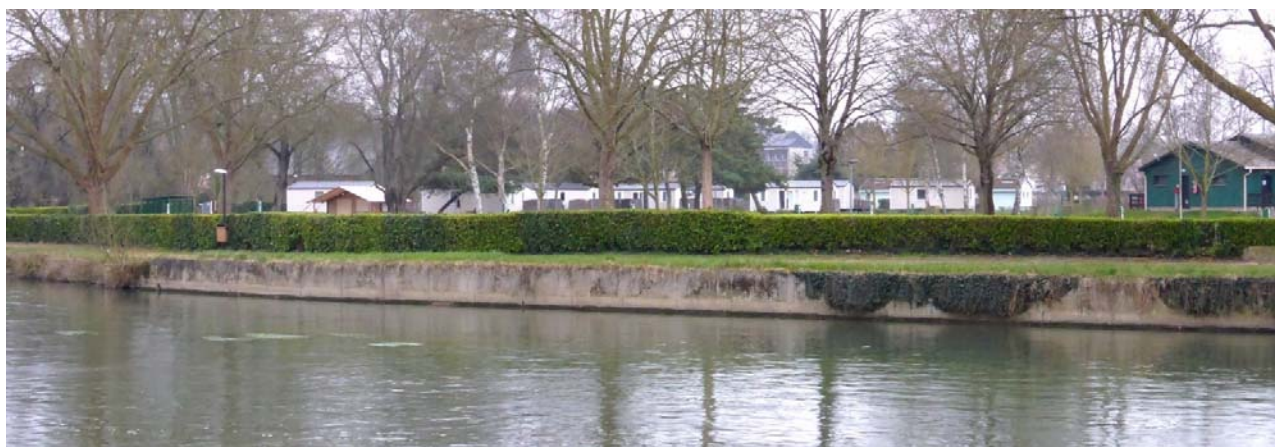
UP19-50-04 – La prolifération des équipements touristiques de type aire de camping créé des enjeux forts en matière d'intégration de ces équipements régulièrement localisés aux abords directs de la rivière (La Flèche)
