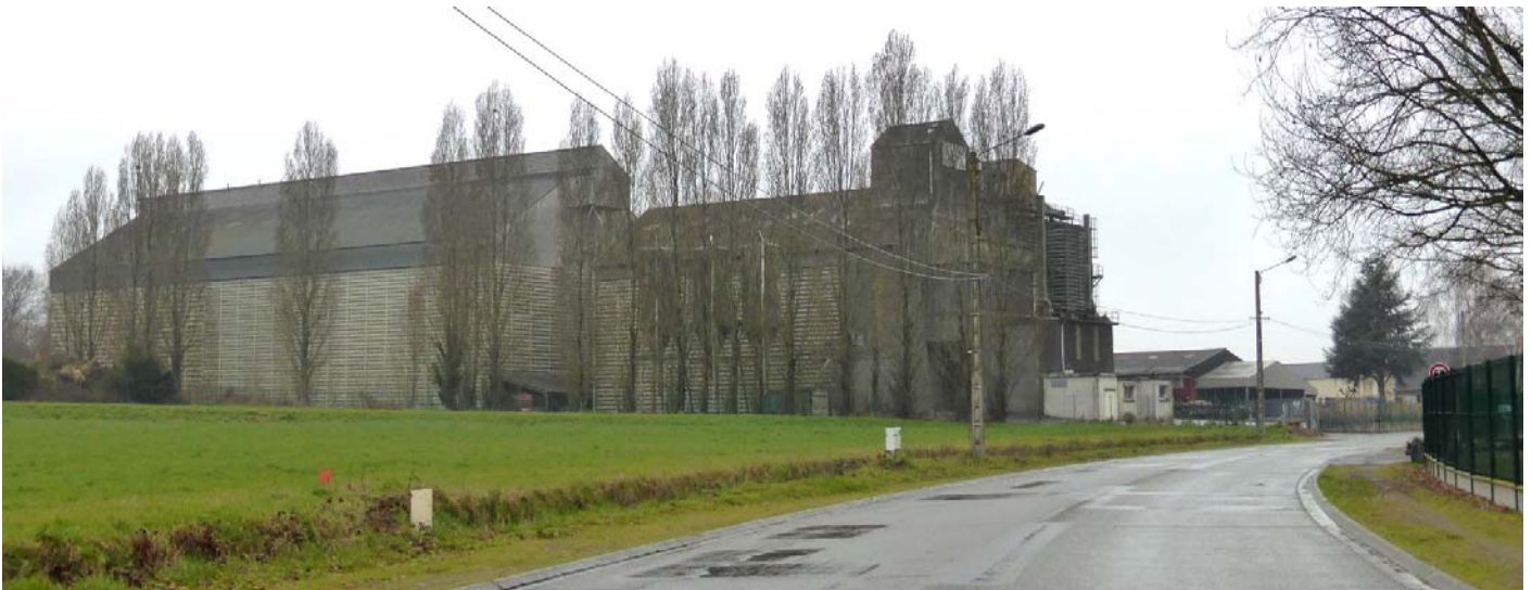
UP19-50-08 – L'aménagement d'un alignement d'arbres peut favoriser l'intégration d'un bâti imposant (Le Lude)
