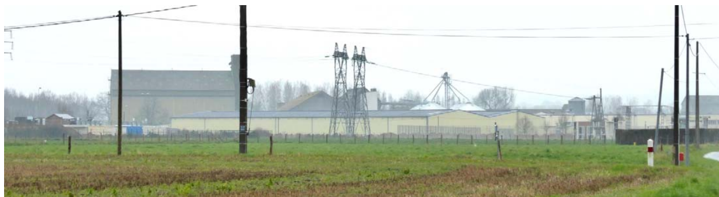
UP19-40-11 – Entre silos, bâtiments techniques, entrepôts et lignes électriques, le secteur de la gare possède son propre paysage à l'ambiance industrielle (La-Chartre-sur-le-Loir – 2015) Avec la fermeture de la vallée due à la densification des boisements, la réhabilitation de l'ancienne sablière en plan d'eau imposant, la diffusion des activités aux abords des axes contribue à décentrer le développement de la vallée et ainsi détourner les regards du Loir et diminuer son inscription visuelle dans le paysage.
