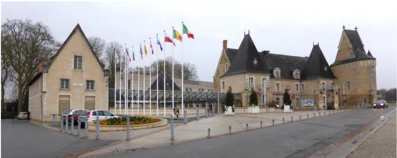
UP19-50-01 – La mise en valeur du patrimoine identitaire de la vallée est assurée notamment par une intervention qualitative sur les aménagements de l'espace public (La Flèche)
