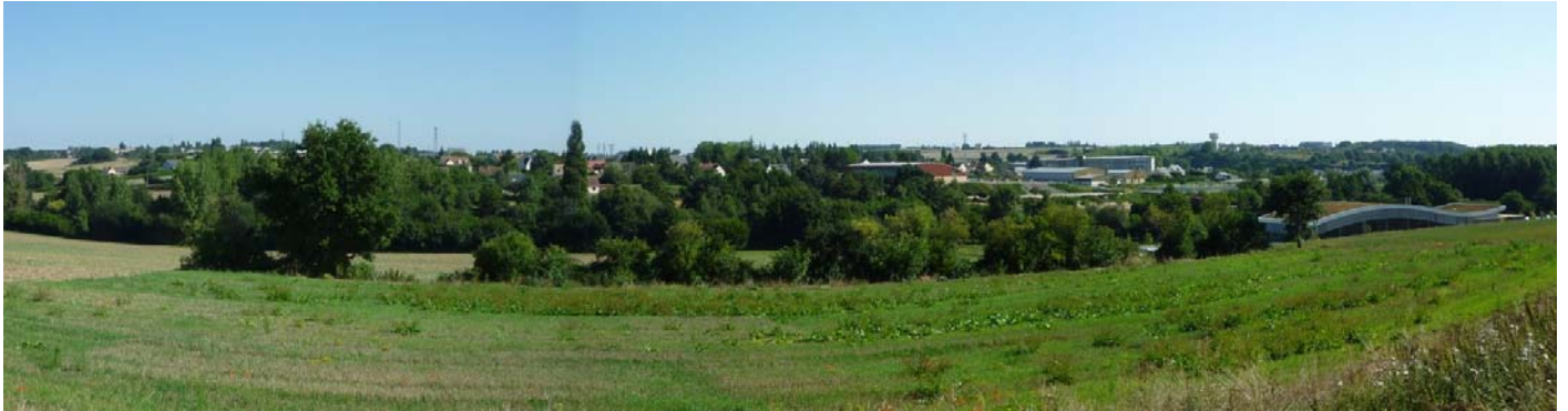
UP19-30-04 Développement de Château-du-Loir sur les coteaux et rebords de plateaux – ruisseau des Profonds Vaux entrée ouest de la ville
