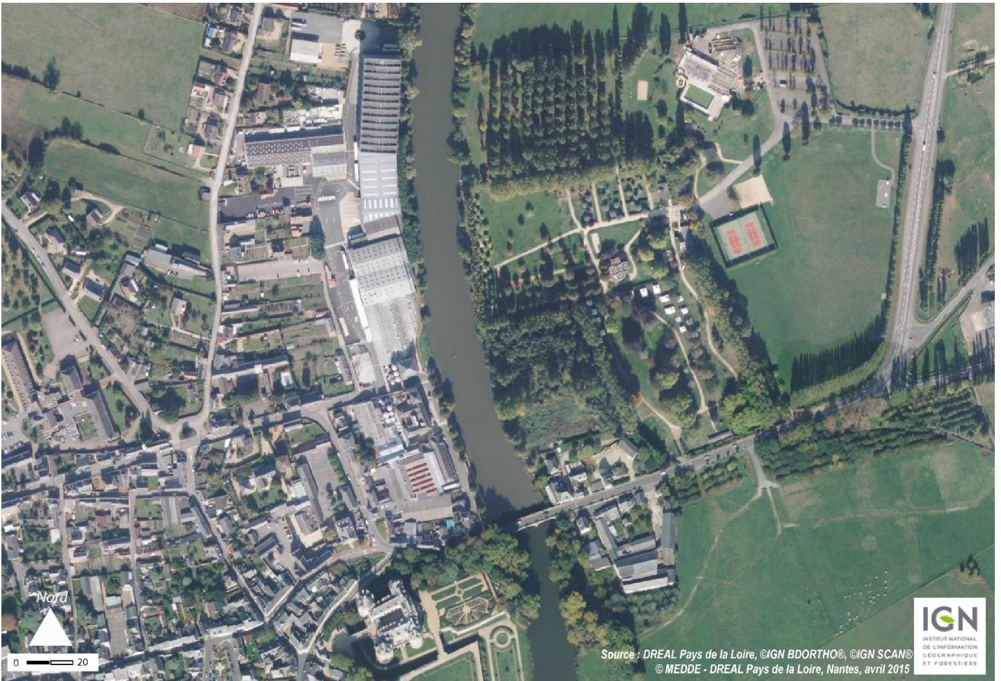
UP19-40-09 – Au niveau du bourg du Lude, les bords de la Sarthe concentrent des développements très hétérogènes : l'extension d'une coopérative laitière, le développement d'un camping et d'une base de loisirs associée et le château et son parc paysager (Le Lude – 2015)
