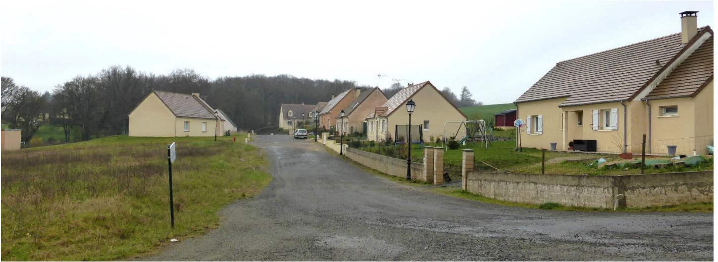
UP19-40-12 -- La diffusion de l'urbanisation se matérialise par des extensions pavillonnaires sur les coteaux -- (La-Chartre-sur-le-Loir -- 2015)
