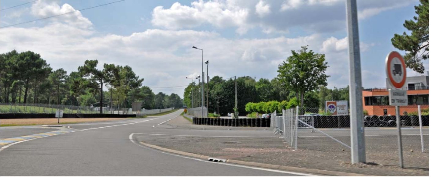
UP15-10-05 Paysage périurbain boisé du sud manceau marqué par les infrastructures des circuits automobiles (Mulsanne)
