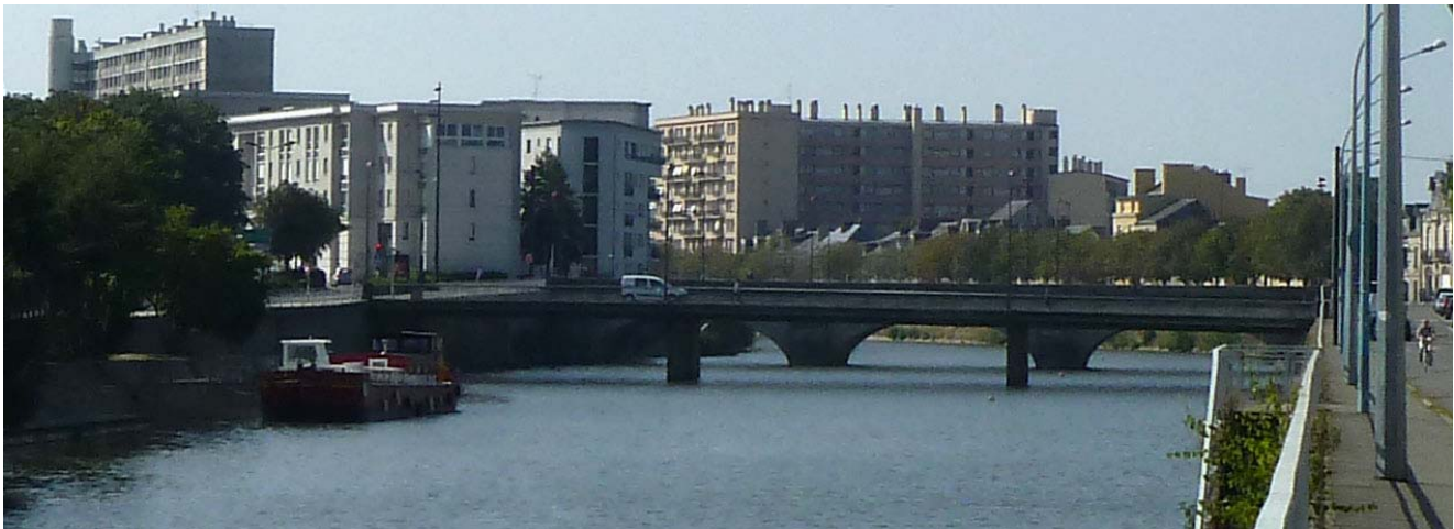
UP15-32-00Bis Un paysage urbain rivulaire alternant les ambiances en fonction des quartiers traversés, la Sarthe entre le parc longeant les murailles de la ville historique et les maisons des anciens faubourgs (Le Mans)
