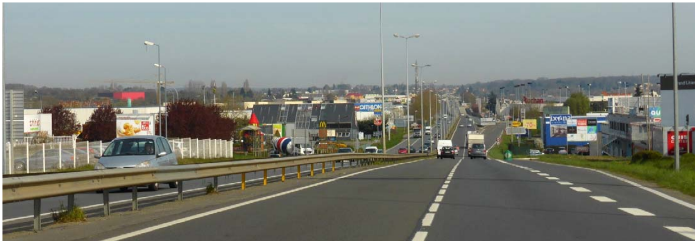
UP15-40-02- Multitude d'enseignes et de bâti d'activités commerciales dans la zone économique Nord, le long de la D338 dans la ZAC des Portes de l'Océane. (Le Mans – 2015)
