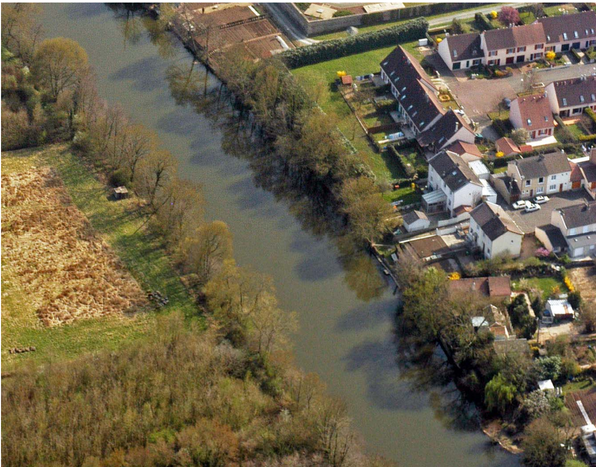
UP15-32-07 Des quartiers pavillonnaires qui semblent privatiser la Sarthe au fond de leurs jardins (Le Mans) (source : CAUE de la Sarthe, 2003)
