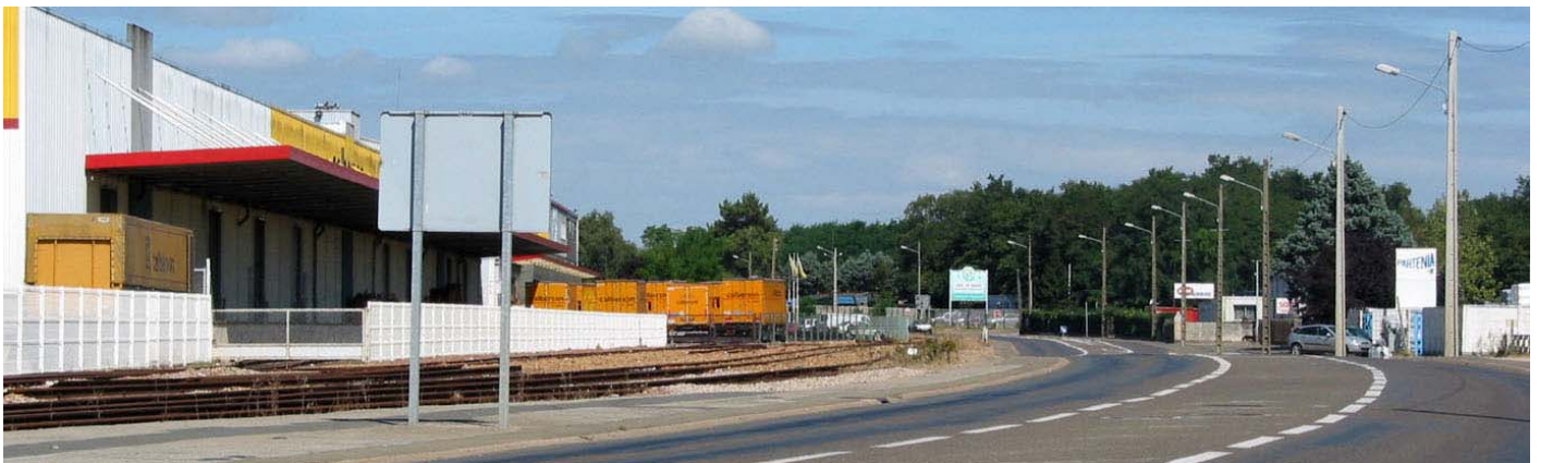
UP15-34-04 Un paysage de zones d'activités marqué par les imposants bâtiments en bardage métallique, les zones de stockage, les enseignes le long des voiries largement dimensionnées (Le Mans)
