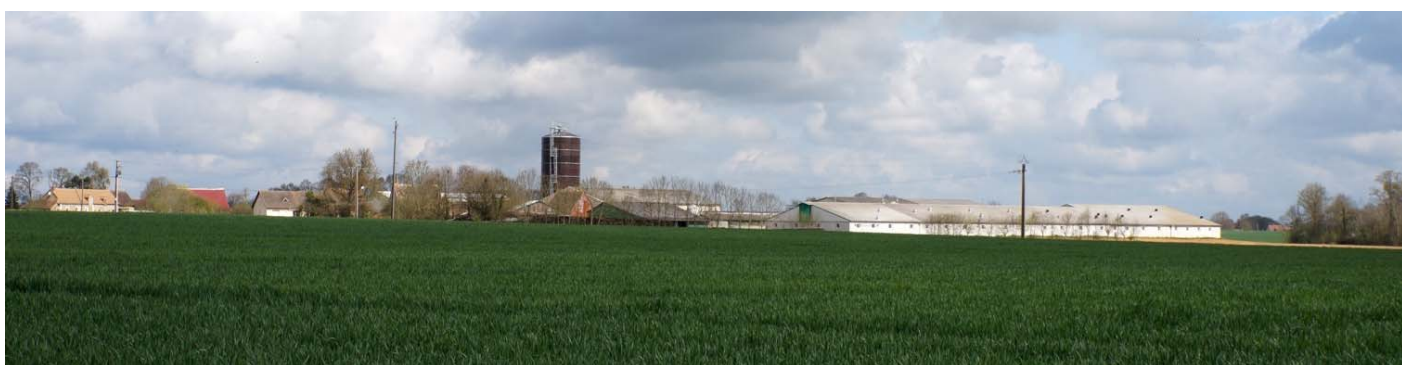
UP14-20-06bis Bâtiment d'exploitation étendant l'emprise du bordage et dominant de ses volumes et matériaux le bâti traditionnel (Saint-Georges-du Rosay)
