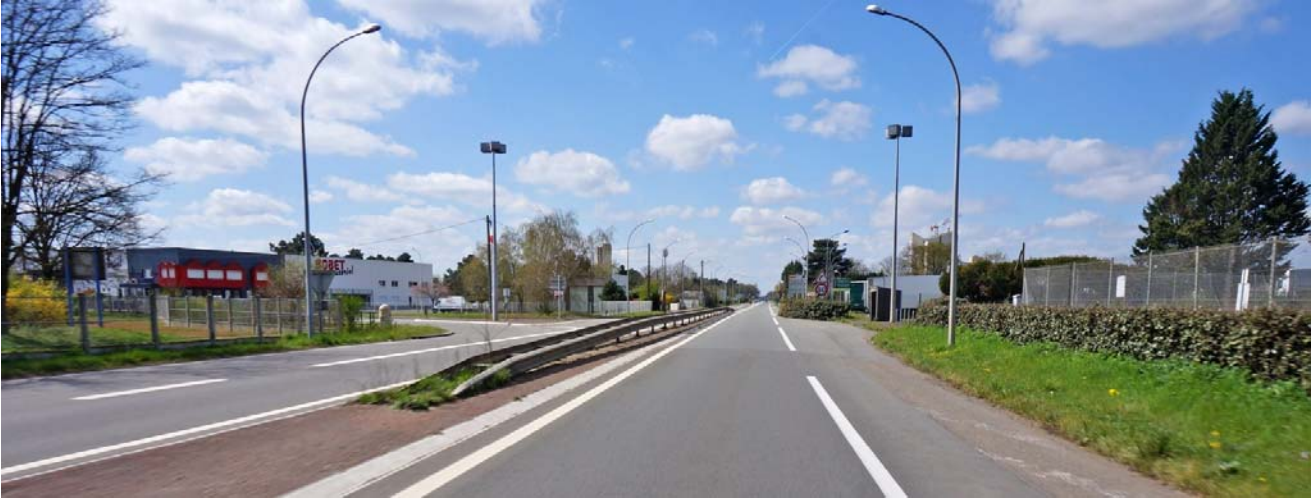
UP14-10-01 Paysage routier monumental de l'entrée est de l'agglomération mancelle (Champagné)
