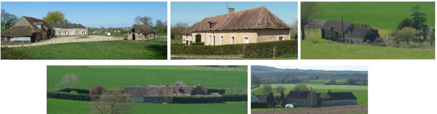
UP11-20-16 Exemples de bâti rural sur la commune de Ballon
