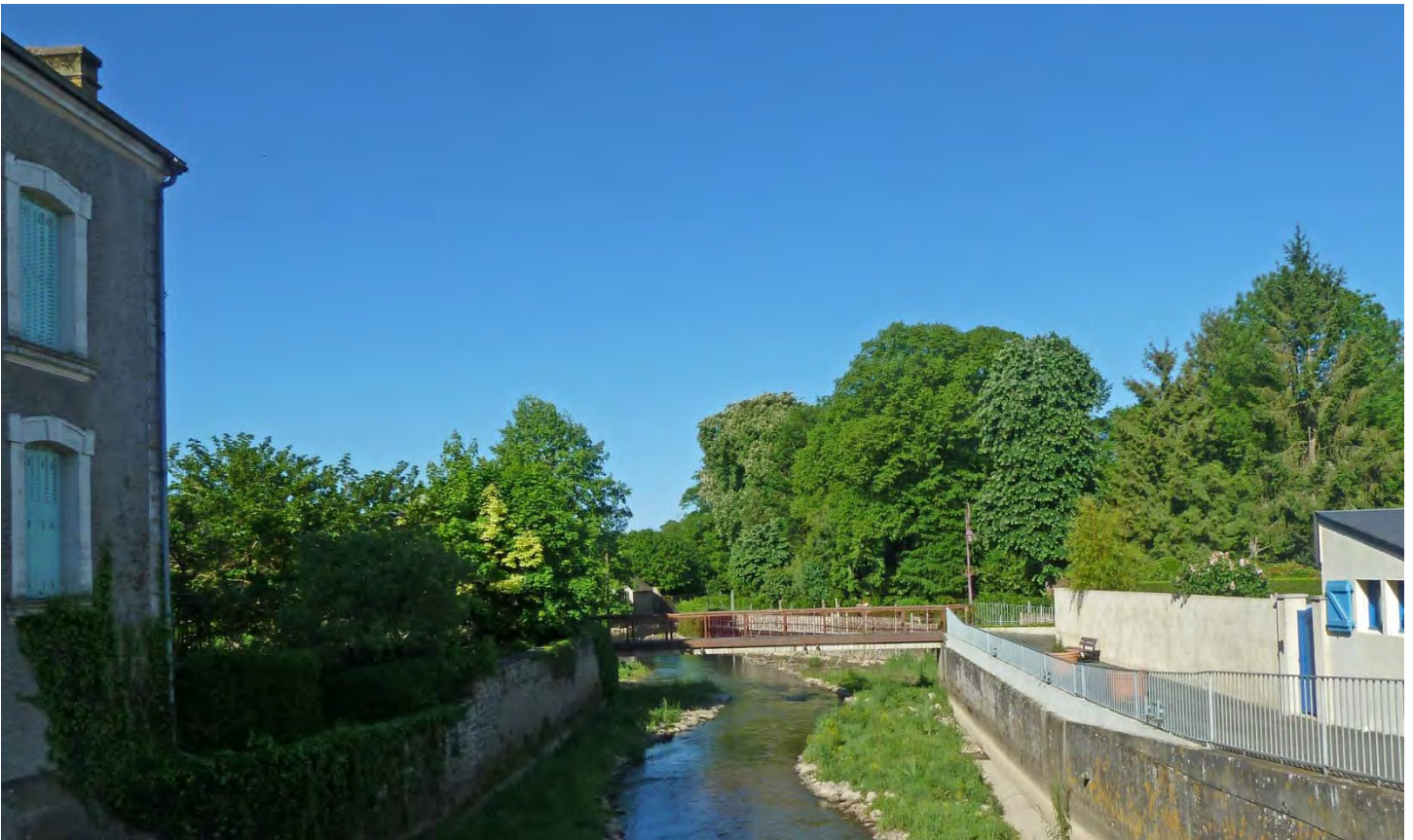
UP8-32-04 Des bourgs qui s'installent sur les parties les plus hautes du bassin mais qui gardent une relation intime à l'eau (Monstsûrs)
