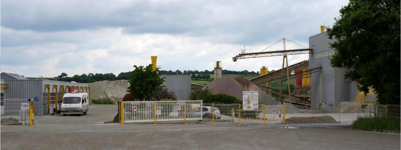
UP8-20-41 Des infrastructures de carrières qui créent des repères industriels dans le paysage de bocage (Voutré)
