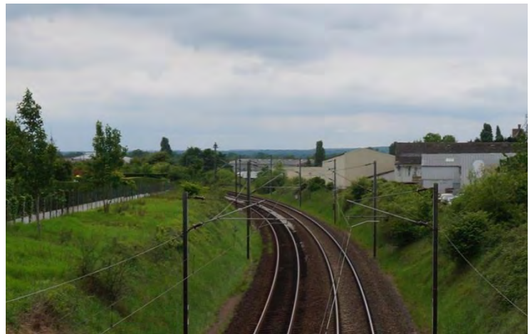
UP08-40-XXX La présence de voie ferrée est davantage signalée par le développement des bâtiments d'activités à ses abords (Evron – 2015)
