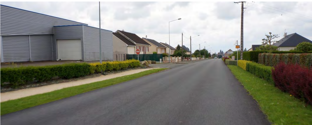
UP8-20-40 Paysage des extensions urbaines d'Evron marqué par des quartiers pavillonnaires et des zones d'activités (Evron)
