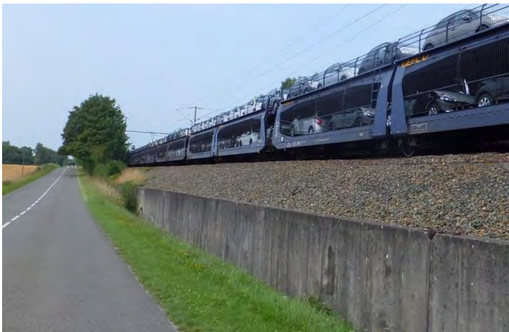
UP08-40-XXX la surélévation de la voie ferrée dans un paysage assez horizontale accentue la visibilité de l'infrastructure (Brée – 2015)
