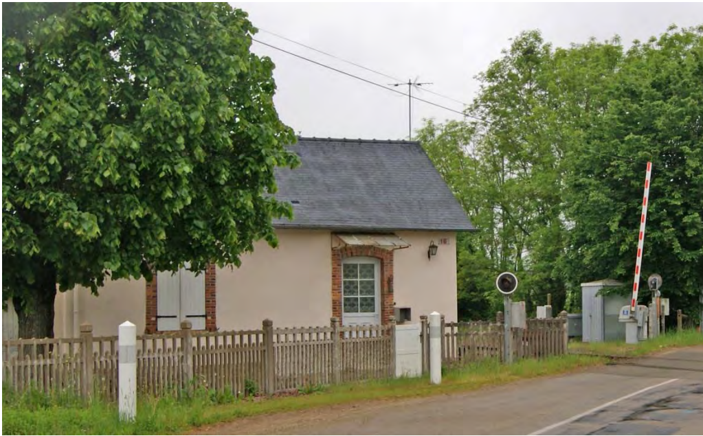
UP00-e Maison de garde barrière (Grez-en-Bouère)
