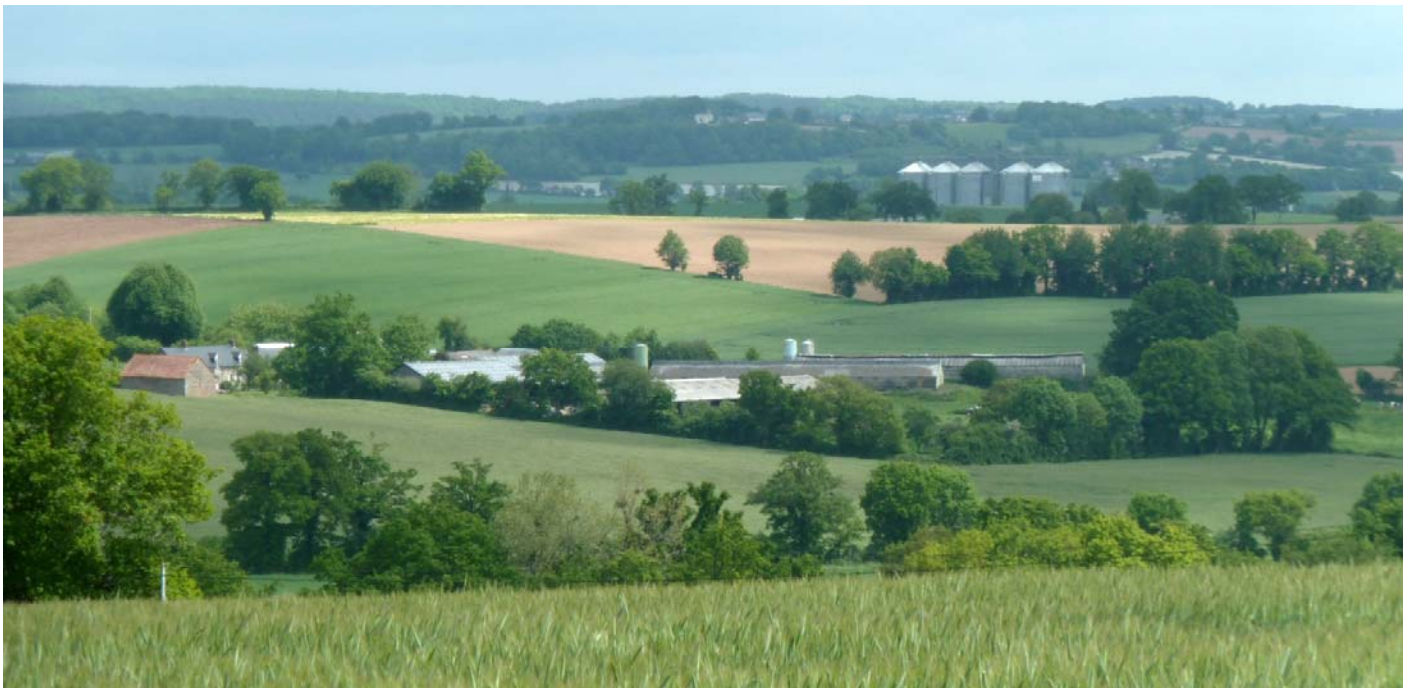
UP08-20-35 Des bâtiments d'exploitation contemporains monumentaux dont l'intégration tient à la persistance des haies bocagères (Saint-Mars-du-Désert)
