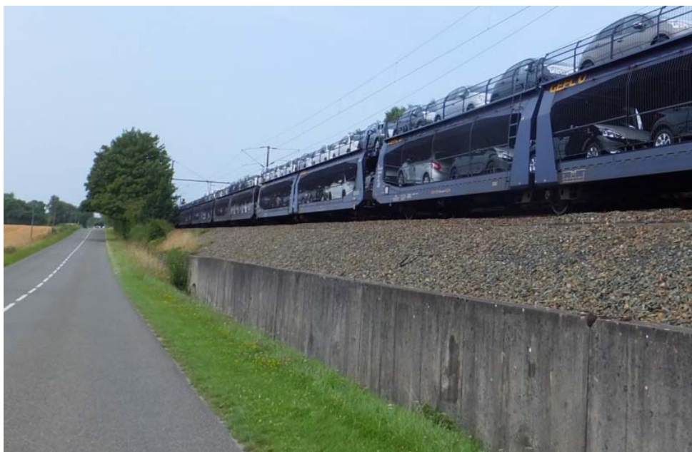
UP08-40-23 la surélévation de la voie ferrée dans un paysage assez horizontale accentue la visibilité de l'infrastructure (Brée – 2015)
