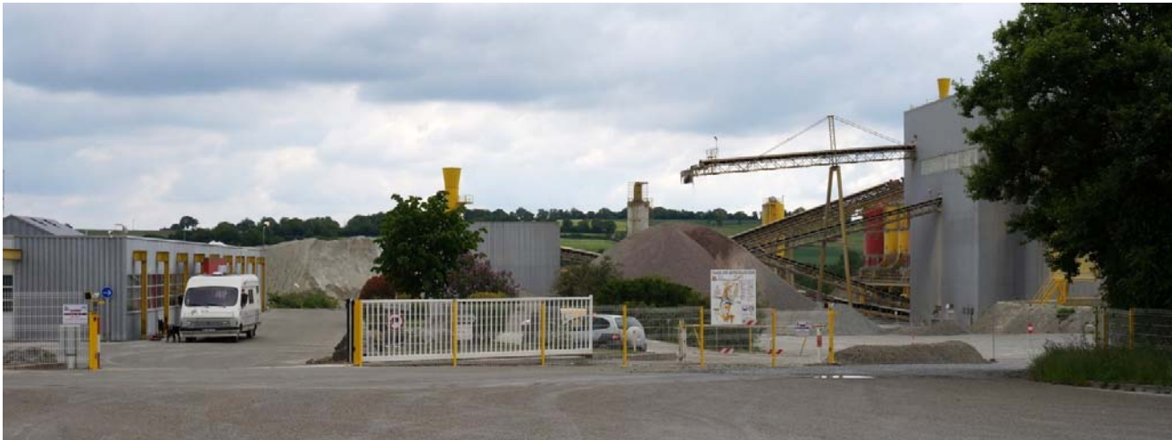
UP08-20-41 Des infrastructures de carrières qui créent des repères industriels dans le paysage de bocage (Voutré)
