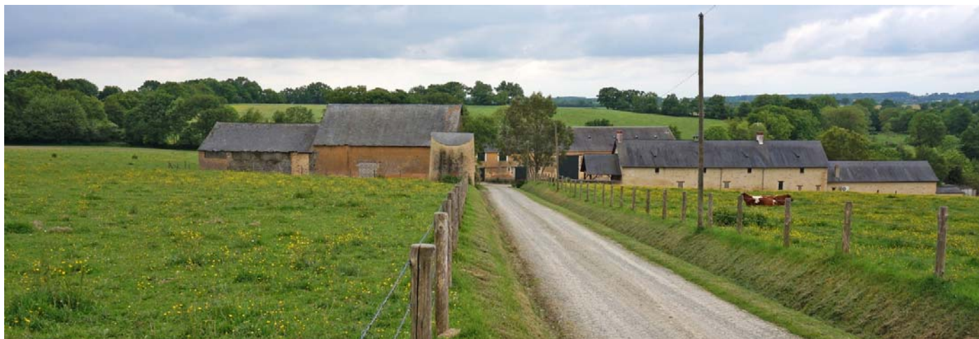
UP08-20-33 Un bâti qui s'organise en longère suivant les courbes de niveau et abritant une cour exposée au sud (Rouez)
