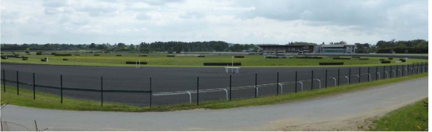
UP07-40-11 L'hippodrome de Meslay-du-Maine constitue un élément paysager imposant avec notamment l'aménagement des bâtiments (gradins) dédiés à l'accueil du public (Meslay-du-Maine – 2015)
