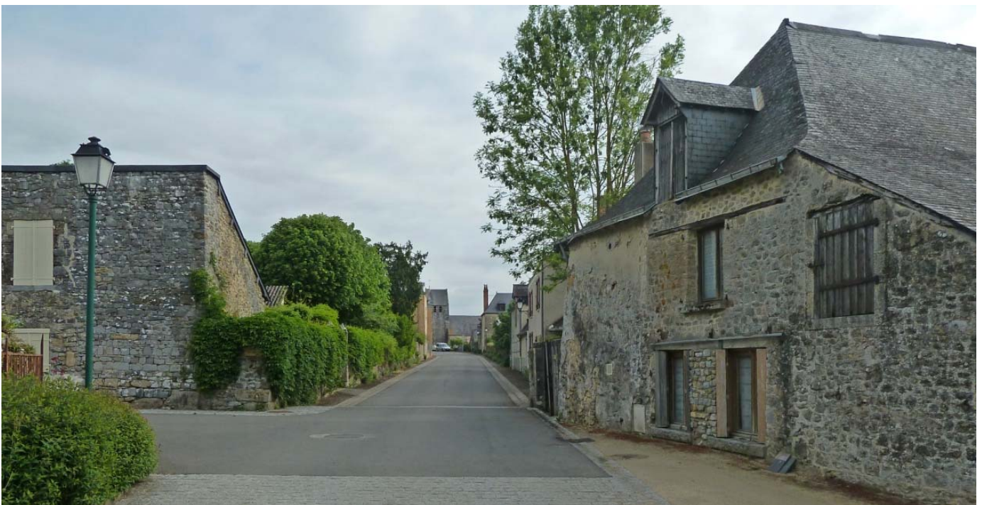
UP07-20-09 Un bâti avec des murs de granit et des toits d'ardoise qui renvoie à l'identité mayennaise (Saint-Pierre-sur-Erve)
