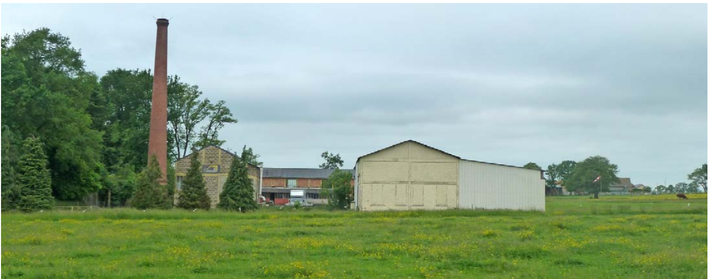
UP05-20-07 architecture industrielle caractéristique des briqueteries (La-Bazouge-de-Chemeré)
