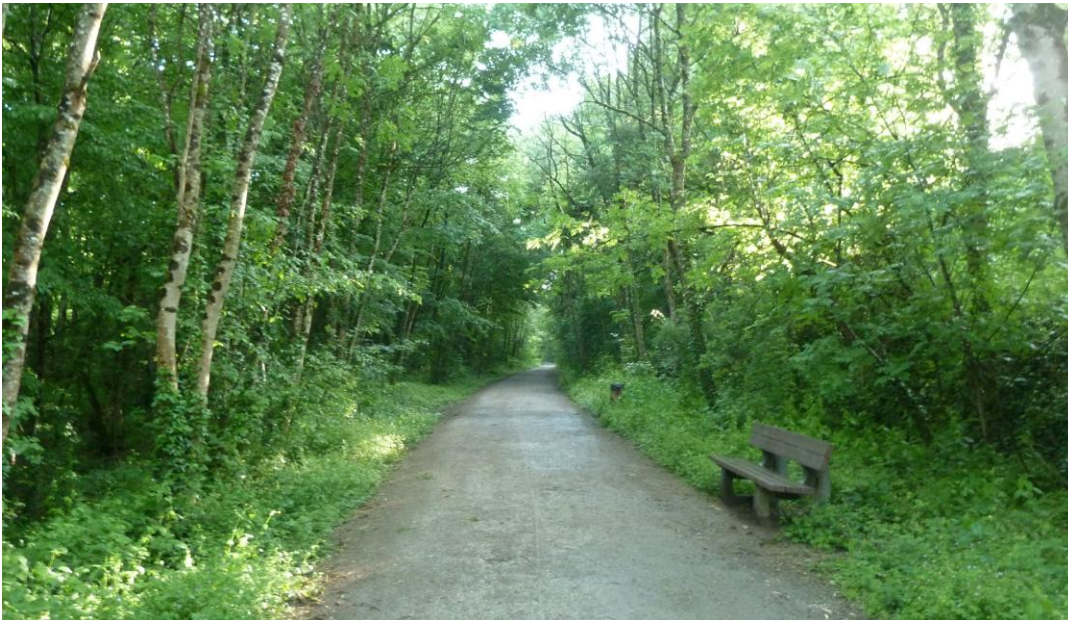
UP06-30-15 Voie verte entre vallon du Vicoïn et Forêt de Concise sur l'ancienne voie ferrée Laval - Renazé
