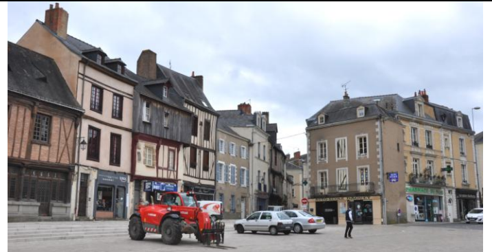
2 Un bâti patrimonial de grande qualité qui souffre de la vacance (Laval)
