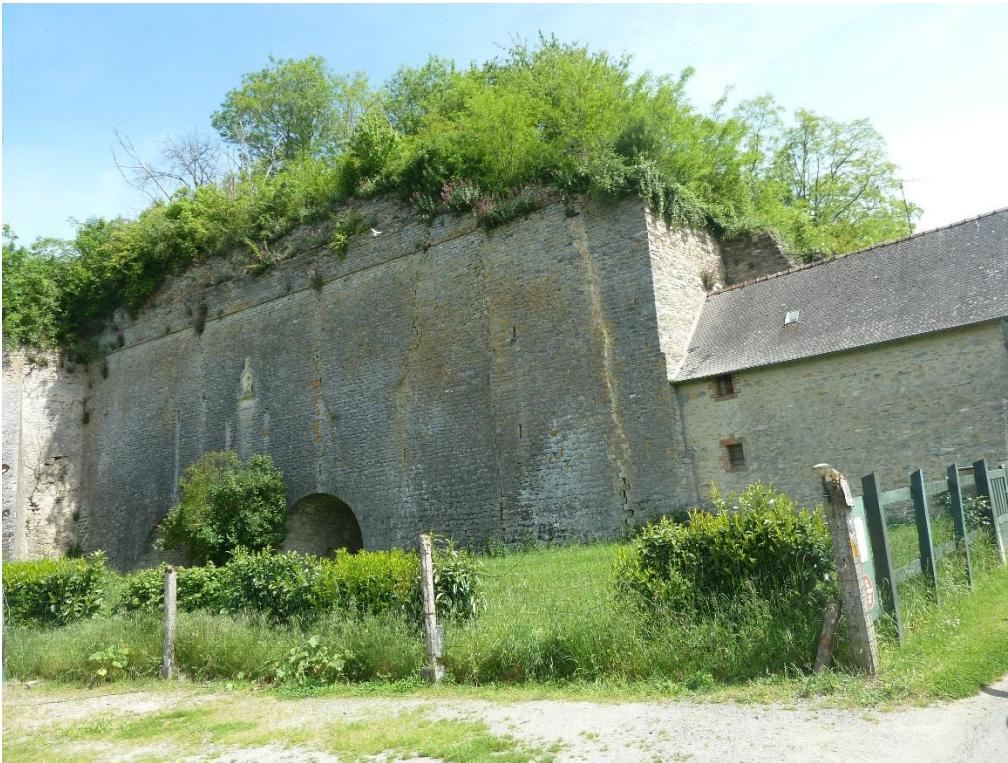
UP05-20-05 Ancien four à chaux de Pamé-sur-Roc
