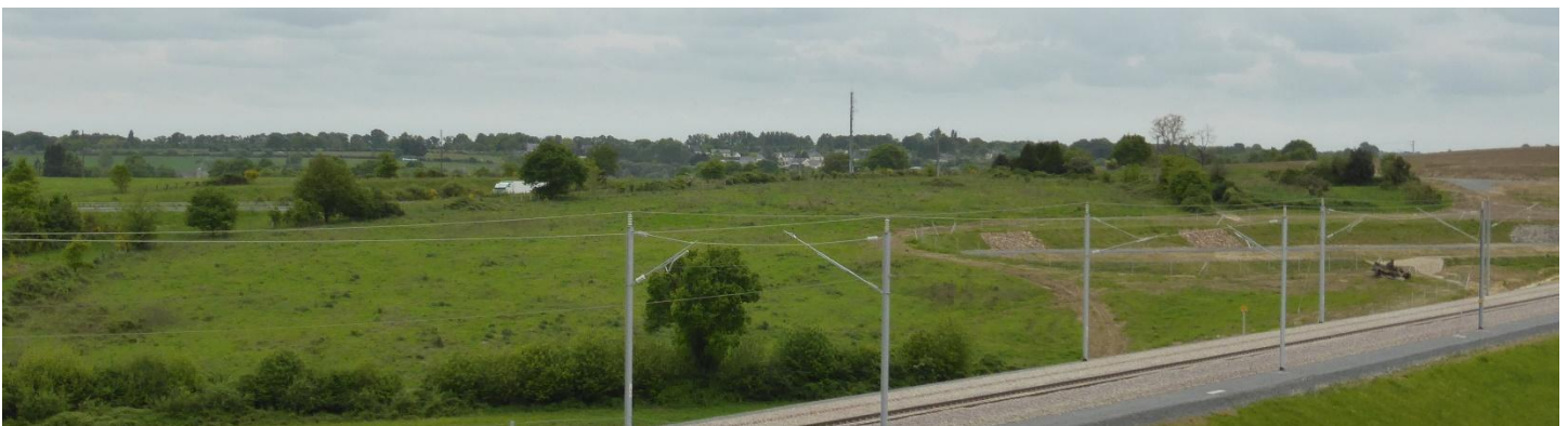
UP06-40-XXX Au nord de Laval, l'aménagement de la ligne LGV reliant Le Mans et Rennes inscrit une nouvelle infrastructure dans le paysage auprès de l'A81 (Changé - 2015)
