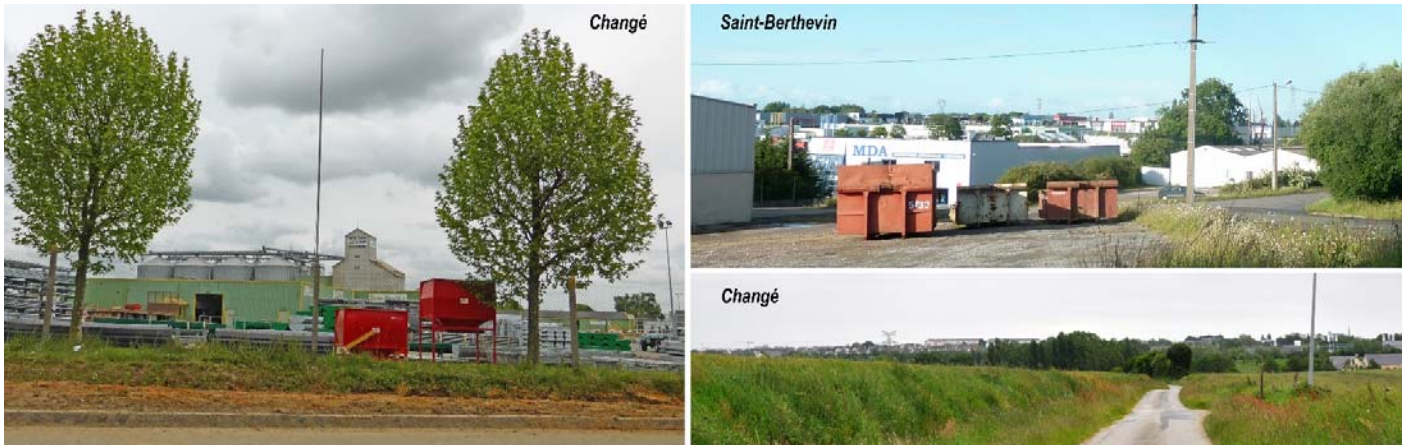
UP06-30-14 Un paysage composite marqué par les activités le long des infrastructures et enchâssées au cœur des quartiers résidentiels
