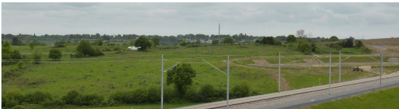
UP06-40-17 Au nord de Laval, l'aménagement de la ligne LGV reliant Le Mans et Rennes inscrit une nouvelle infrastructure dans le paysage auprès de l'A81 (Changé - 2015)
