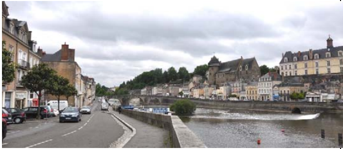
1. Une implantation sur la Mayenne, axe fondateur de l'agglomération : château, front urbain, franchissement, barrage ... (Laval)
