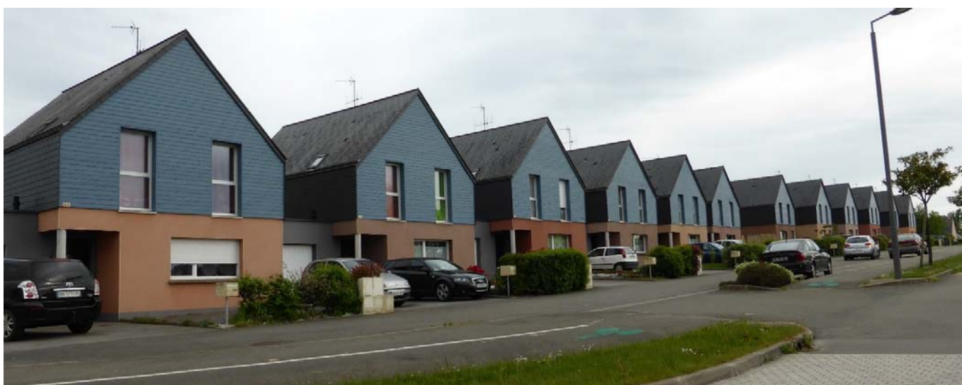
UP06-40-12 A Saint-Berthevin, le quartier de la Prévôtère accueille des constructions nouvelles aux architectures innovantes pour répondre notamment aux enjeux de limitation de l'étalement urbain (Saint-Berthevin - 2015)
