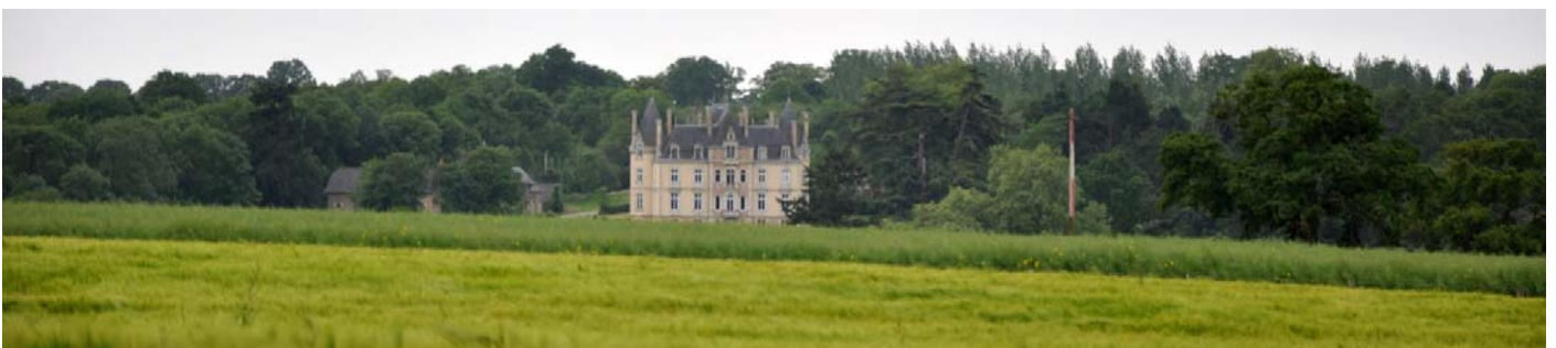
UP06-30-08 Château de la Houssaye, implanté sur le coteau arboré rive droite, dominant la Mayenne au cœur de son parc arboré, que l'on découvre depuis le plateau de l'aérodrome (Laval)
