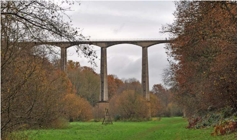
UP03-40-06 Le viaduc ferroviaire sur la Vaudelles de Saint-Georges-le-Gaultier, un point de départ patrimonial pour la pratique du saut à l'élastique.
