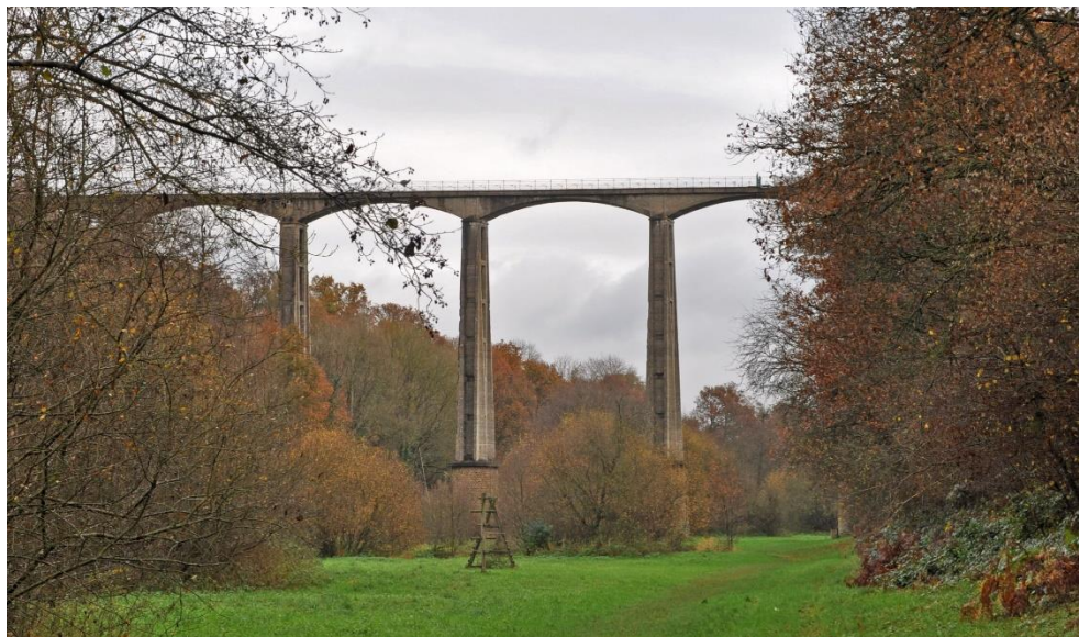
03-40-IM03 Le viaduc ferroviaire sur la Vaudelles de Saint-Georges-le-Gaultier, un point de départ patrimonial pour la pratique du saut à l'élastique.
